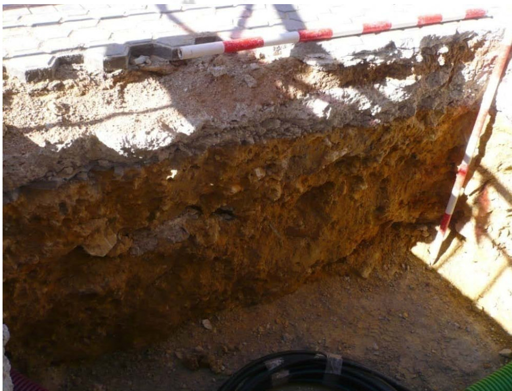
FIG. 4 Perfil en el que se aprecia los niveles asociados al acerado actual, dispuestos Sobre el paquete de matriz arcillosa, albero, zahorra y cascotes.
