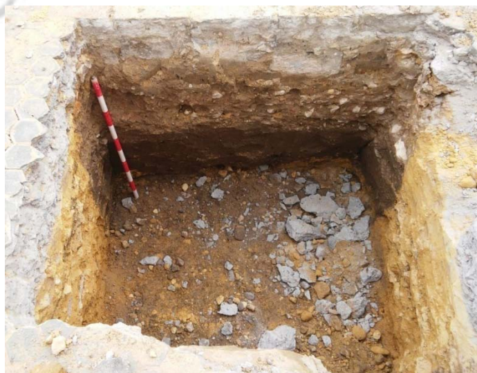
FIG. 8. Vista general de la arqueta
