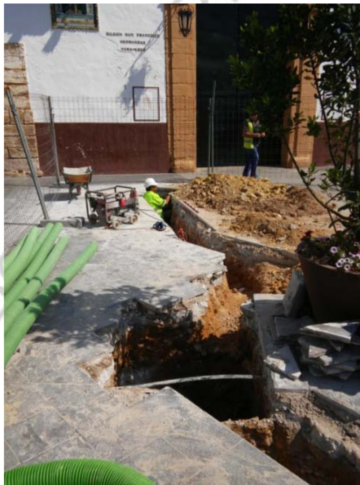
FIG. 1. Zanja de conexión hacia la cámara existente de telefonía.
