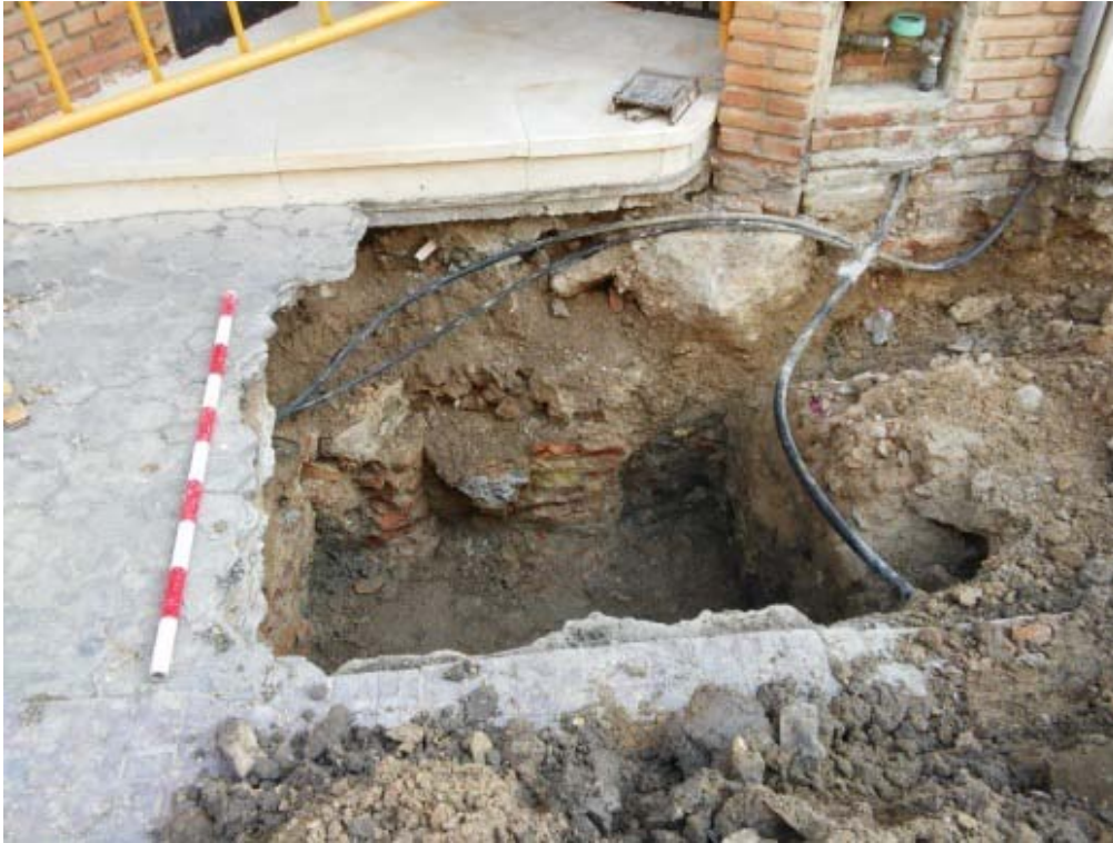
FIG. 2. Sección de colector labrado en ladrillos tomados con mortero de cal. A la derecha los rellenos oscuros acusan la filtración de aguas. Perfil oeste.
