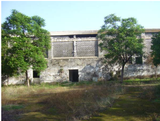
Figura 39. Detalle del muro sur del secadero antes de la intervención
