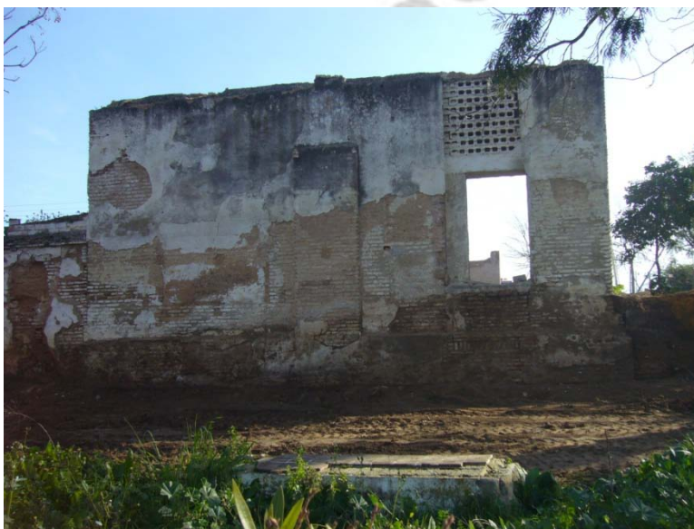
Figura 31. El tramo oeste de la nave tras retirar la rampa de escombros.
