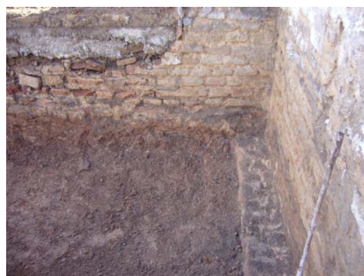
Figura 9. Detalle de la cimentación de los muros en el S3.
