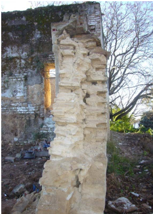
Figura 29. Sección de la tapia donde se observa su desplome y técnica constructiva
