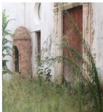
Patio y fachada de la cuadra
