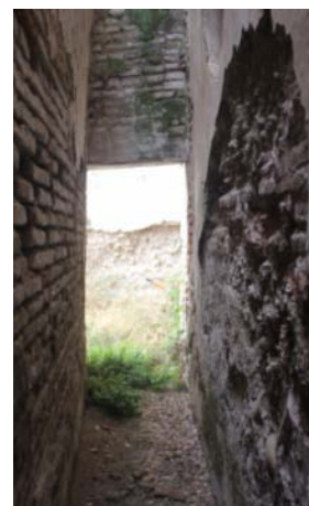
Pasillo de acceso al patio de las caballerizas
