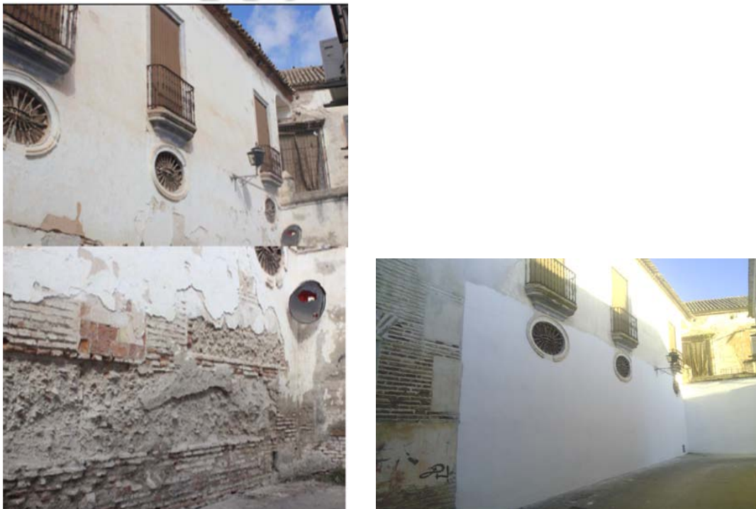
Fig 3. Fachada de la calle Torcal antes y después de la intervención
