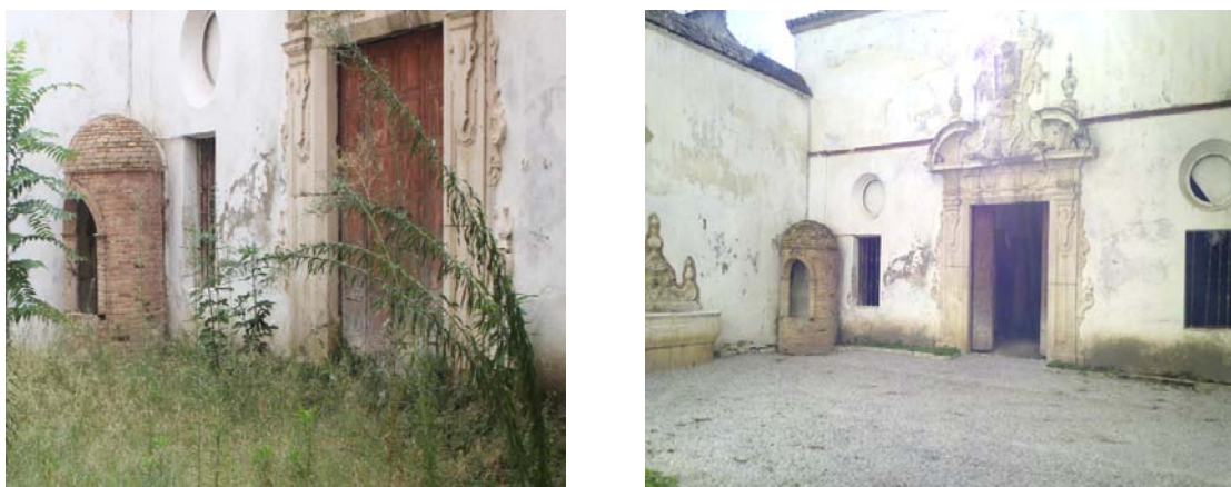
Fig 7. Fachada de la cuadra principal antes y después de la intervención
