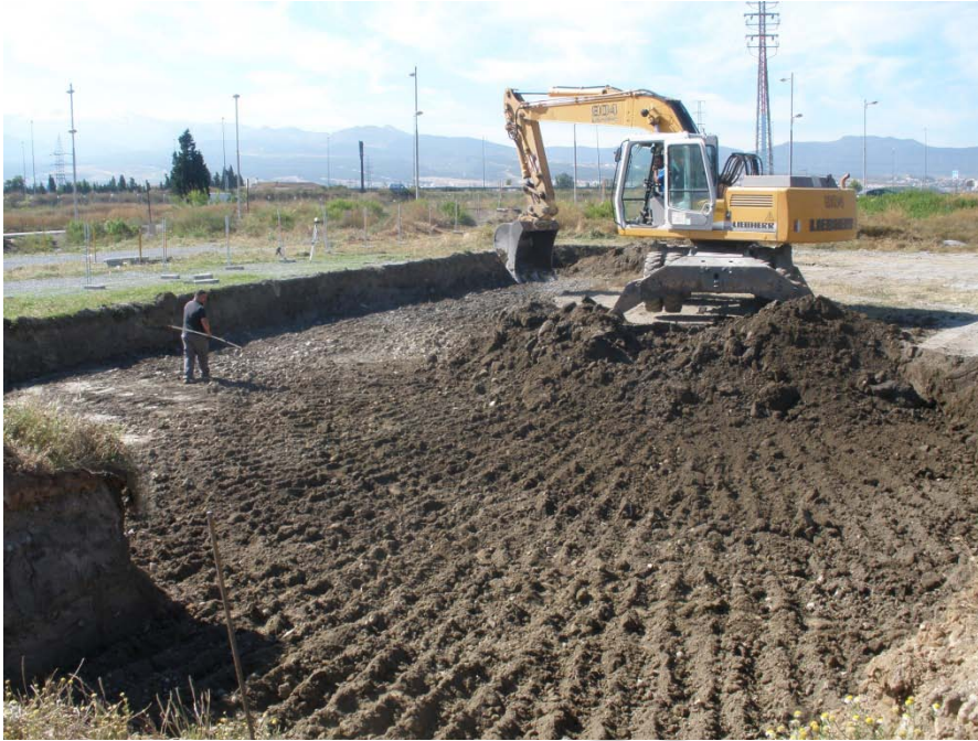
LÁM.3. Excavación en la parte central del solar.
