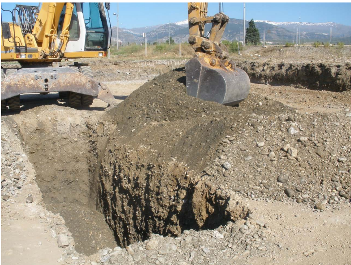
LÁM.8. Relleno de los sondeos.
