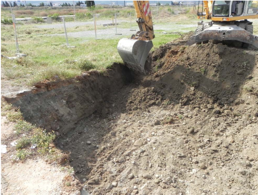
LÁM.1. Excavación mediante cajeadó en la zona noreste del solar.
