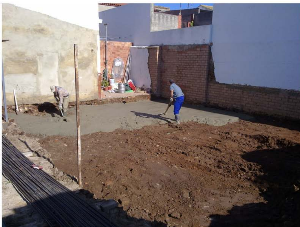
LÁMINA II. Inicios de los Rebajes en Sector Norte, de escasos 0.30 m por la pendiente del solar (arriba). Ejecución coetánea de primera capa de hormigón (abajo)
