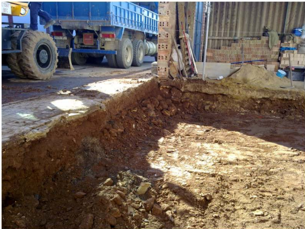
Lámina V. Detalle General Perfil Sur Acerado en Fin de Excavación.
