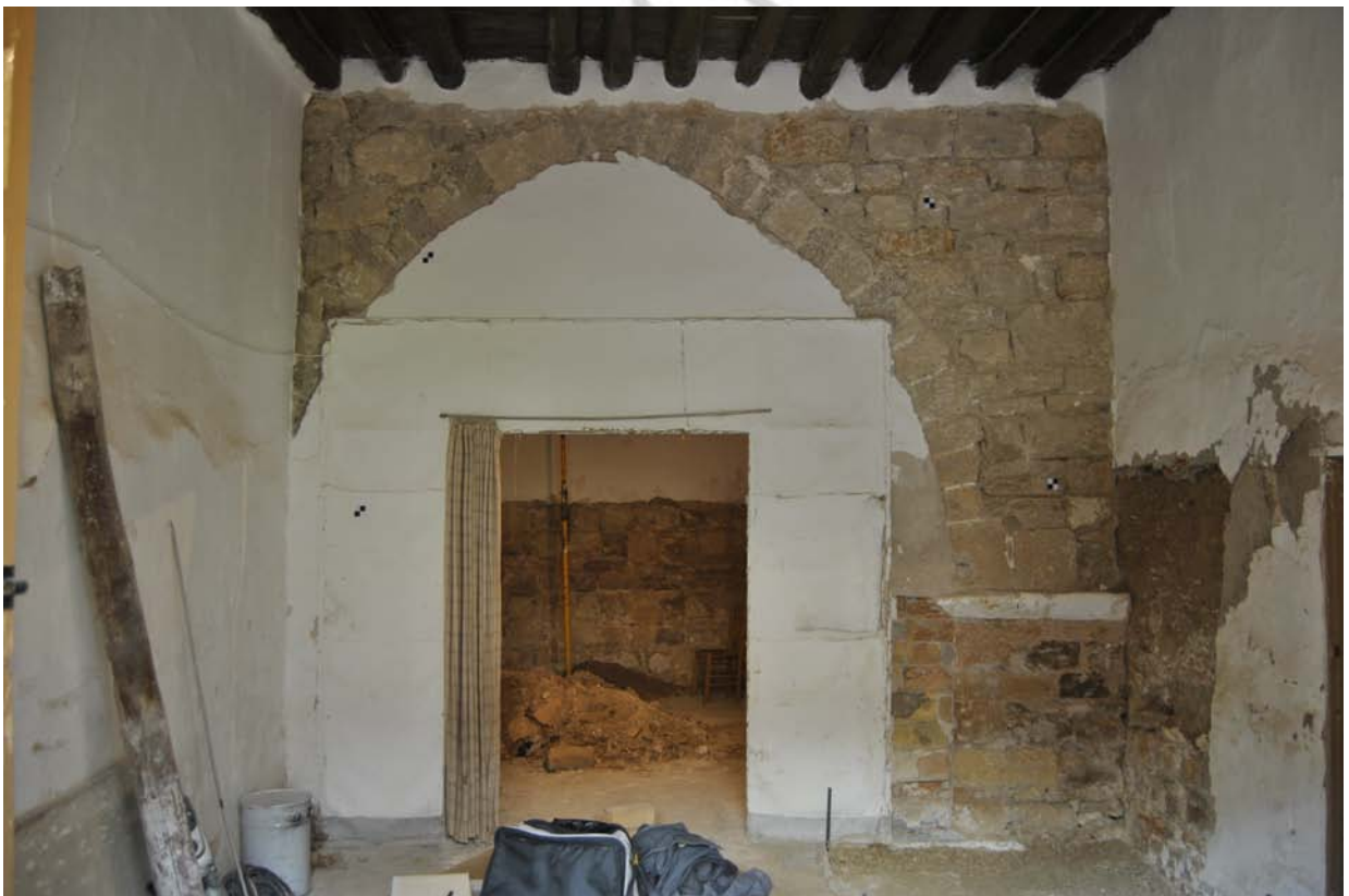
Figura 5: Arcada medieval localizada
