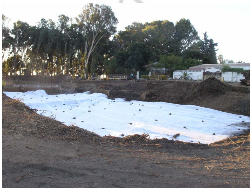
Figura 5. Cubrición con geotextil de una de las áreas excavadas en 1.999.
