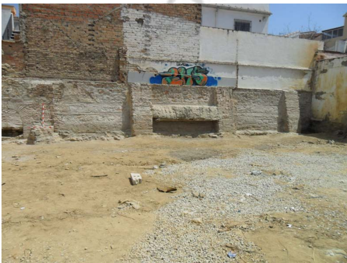
Fig.3. Se observan las U.U.E.E.C.C.11, 12, 13 y 14.
