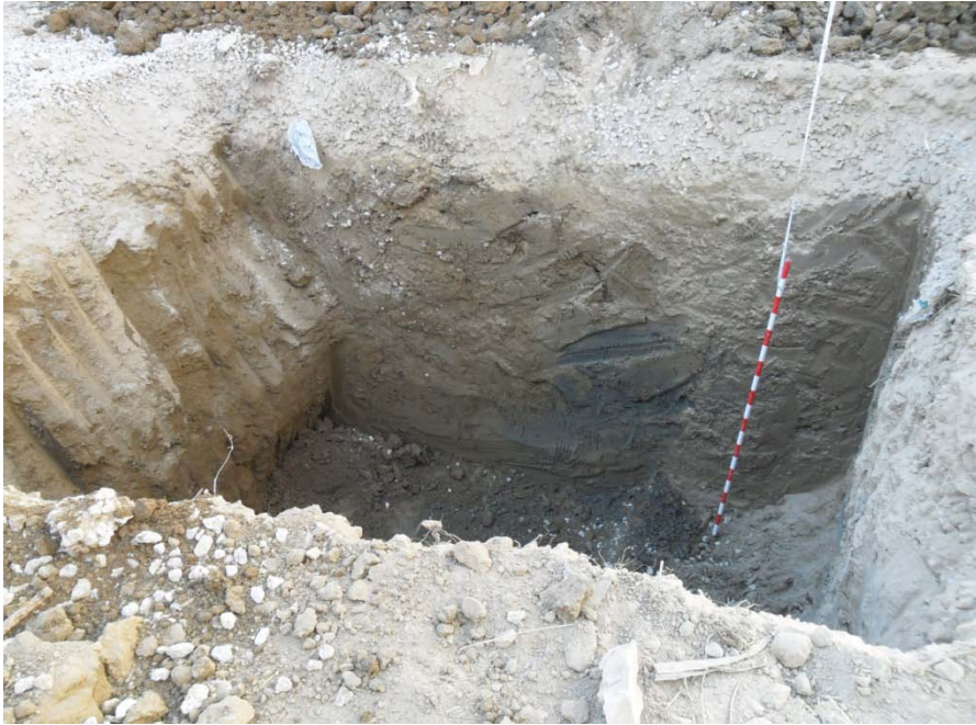
Fig.9. Excavación de la Zanja 1.
