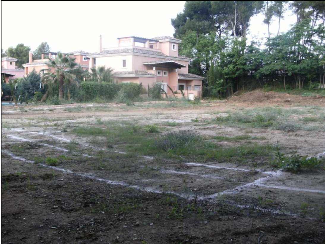
Replanteo de obras previo al inicio de los trabajos.
