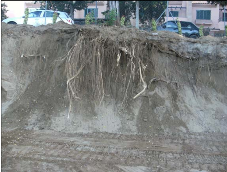
Detalle del talud norte de la zona de obras, en el que se puede apreciar las formaciones de arena que sustentan una ligera cobertera caracterizada por la presencia de abundantes raíces pertenecientes a la vegetación de la zona.
