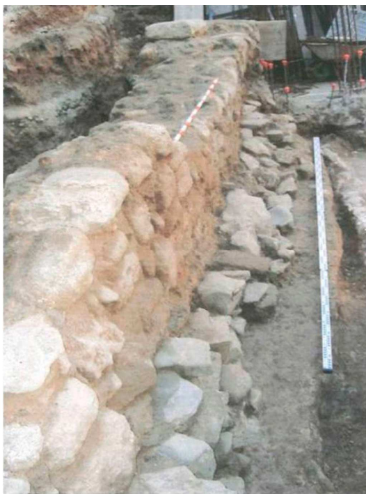
Lám.II: Estructura de contención de aguas.UE:20
