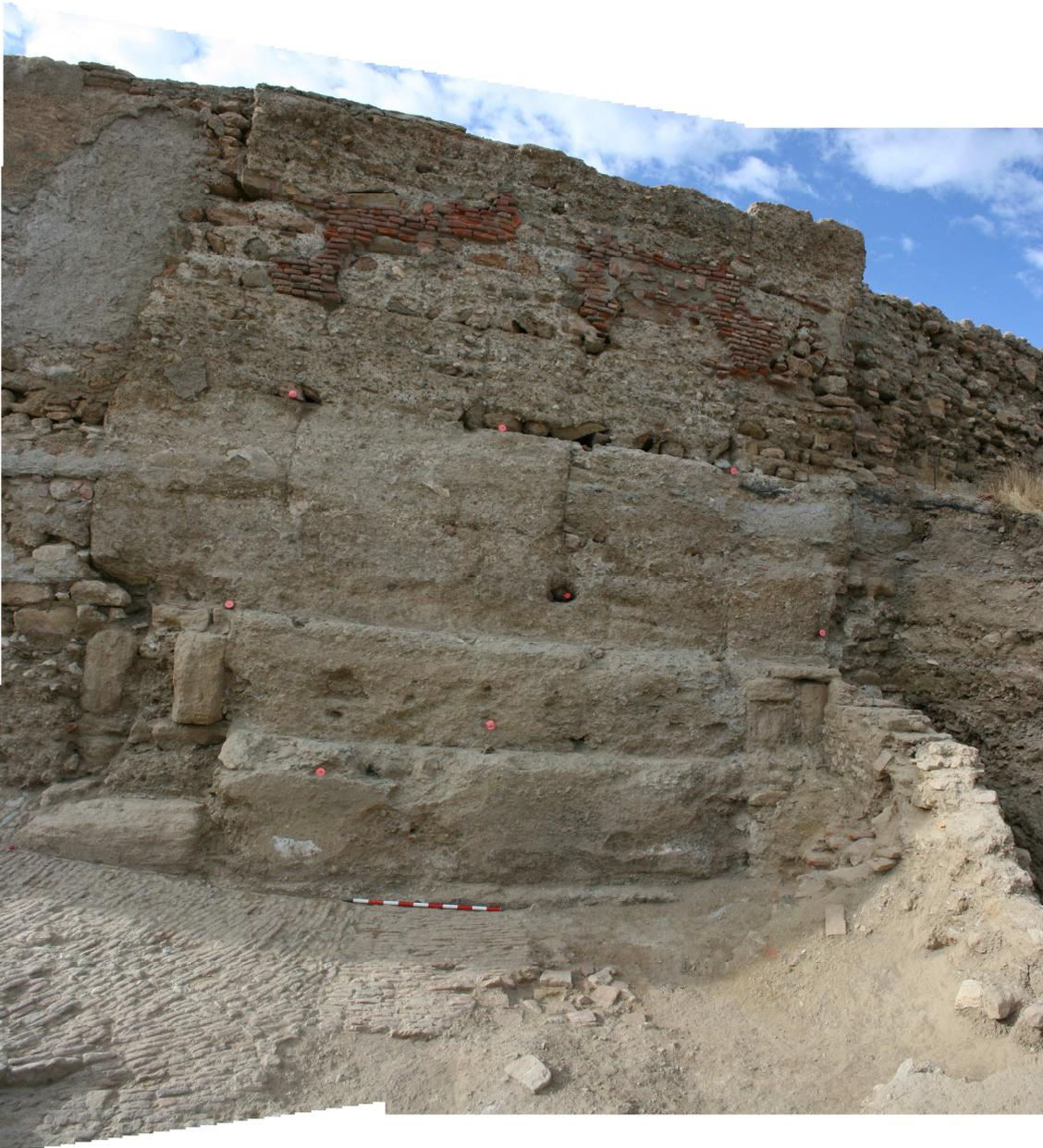
Fig.7.- Torre meridional con las tres zarpas y refuerzo de sillares a soga y tizón en las esquinas. A la derecha puede verse el muro UE 011 apoyando sobre la torre y la rampa de ladrillos (UE 043) haciendo el primer quiebro y apoyándose sobre la tercera zarpa.
