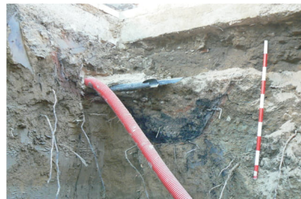
2.4. MANCHA DE COMBUSTIÓN UE 27
