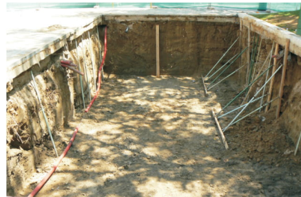
4.3. ENTIBADO DEL ÁREA DE ACTUACIÓN
