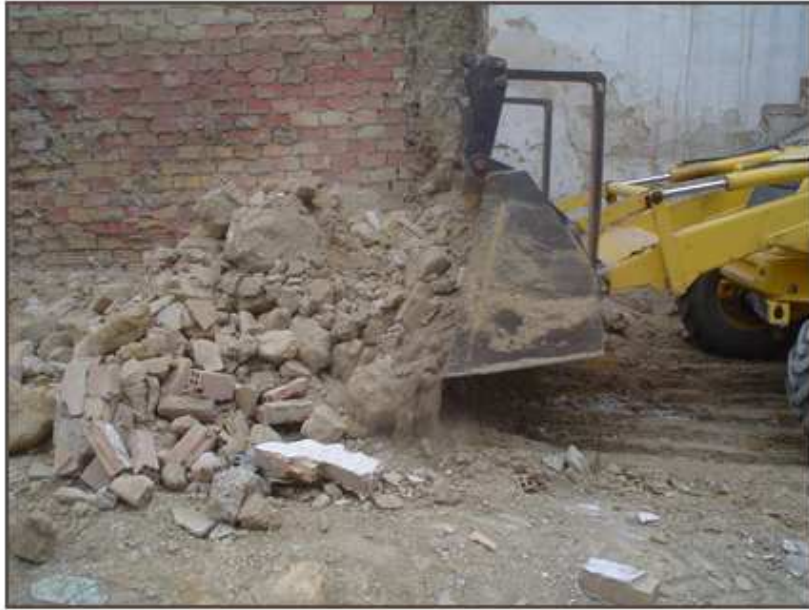
Inicio de las labores de destierro .
