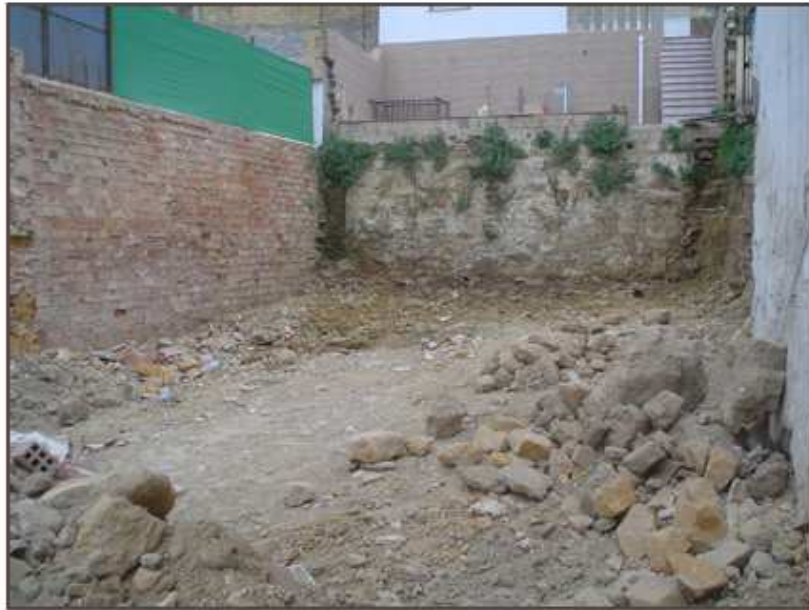
Estado previo del solar
