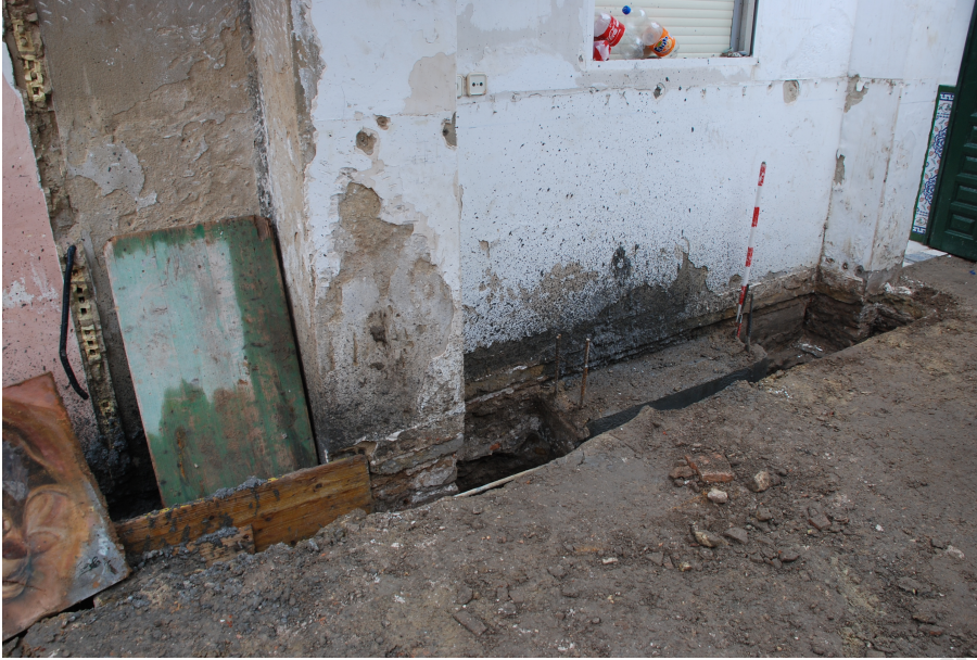
Zanja de cimentación. C1,2,3 y 4.
