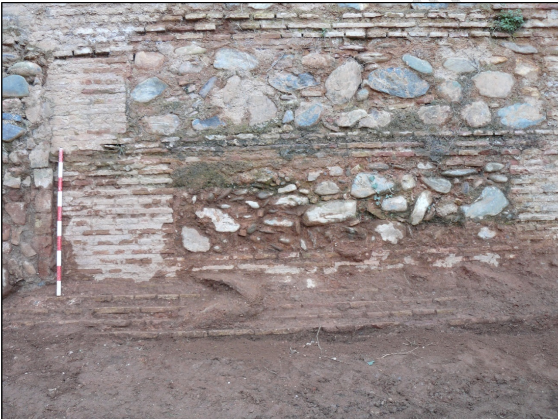
Imagen. Detalle de la cimentación de la muralla en la Secuencia IV
