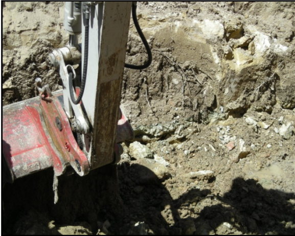
Figura 2 : Proceso de excavación.
