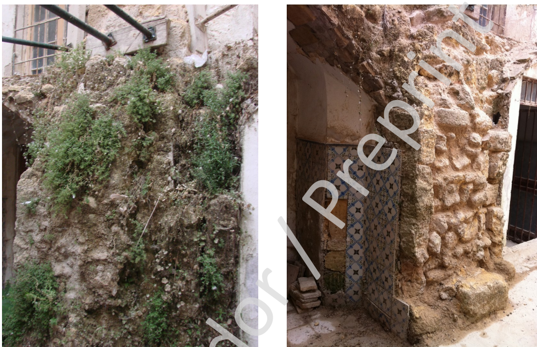
Lám. 38 y 39. Muro de la Sacristía antes y después de su limpieza y consolidación básica
