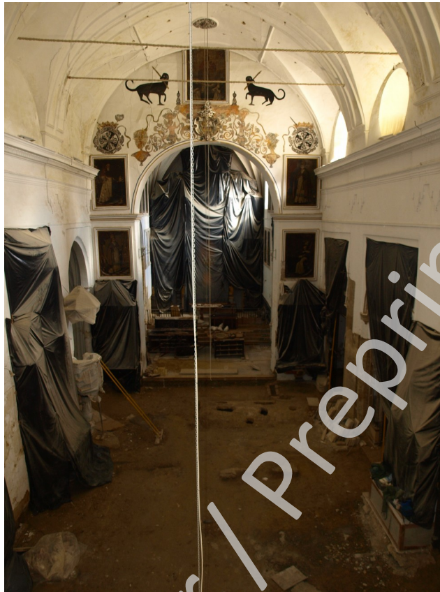
Lám. 2. Vista general de la nave central al finalizar la actividad.
