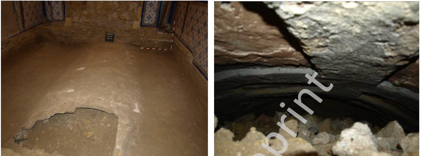
Lám. 24 y 25. Vista y detalle de la cripta 6 y su interior.
