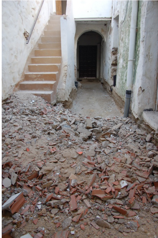
Figura 5. Detalle del pasillo de entrada durante el proceso de vaciado, con abundante material latericio procedente de las cubiertas.
