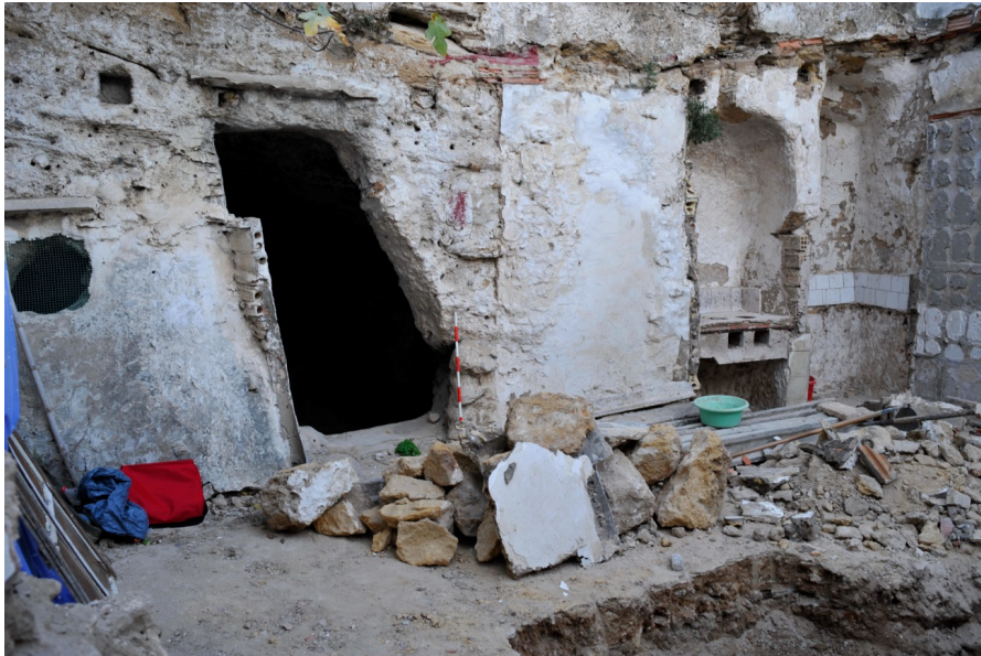
Figura 8. Entrada de la covacha durante el transcurso de las obras.
