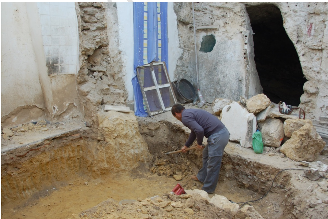
Figura 6. Proceso de vaciado del patio.
