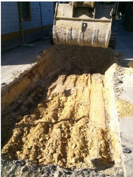
2) Retirada de subbase UE 2
