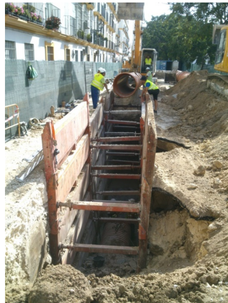
4) Instalación de tubo
