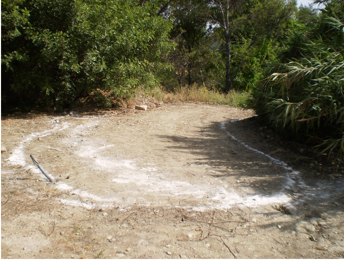
Lám. 8. Planteamiento de la excavación del anfibiario.
