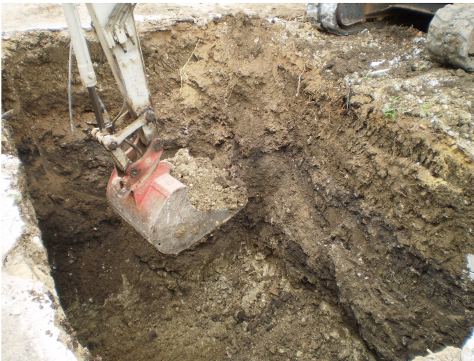
Lám. 3. Excavación del aljibe.
