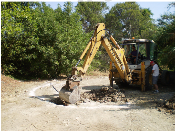
Lám. 1. Trabajos de excavación con retroexcavadora
