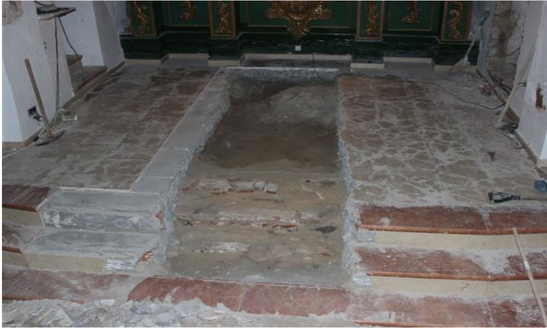
Lámina 3. Vista intervención en el presbiterio.
