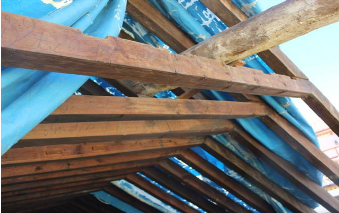
Lámina 5. Vista detalle graffitis en cubierta.
