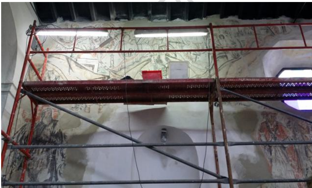
Lámina 6. Vista trabajos restauración de pinturas murales.
