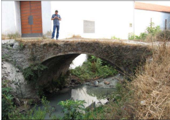
Lam. 5 Tramo 3.2. Puente de la Hiedra
