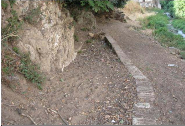
Lam. 10 Tramo 3.2 del Camino del Chorrillo. Travertino en el talud, arroyo de la Villa al fondo
