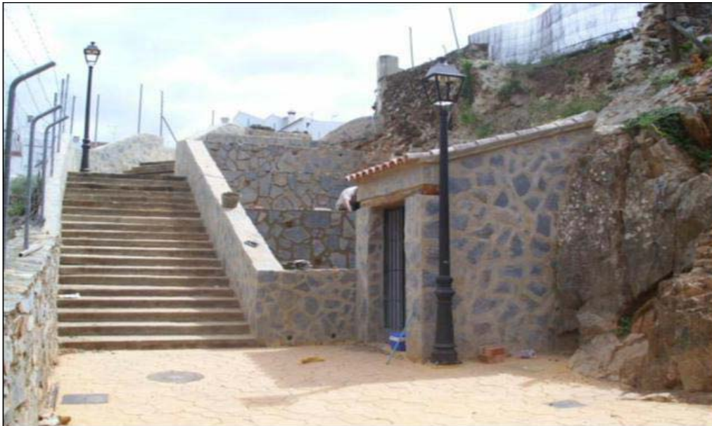
Lam. 4 Tramo 2 del Camino del Chorrillo. Terminación, primer plano marco protector de la puerta de la Cueva de la Sima.
