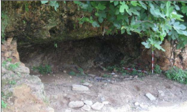
Lam. 12 Tramo 3.2 del Camino del Chorrillo. Covacha artificial excavada en el travertino
