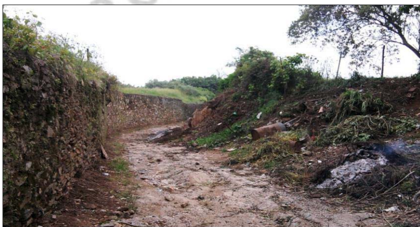
Lam. 1 Tramo 1 del Camino del Chorrillo. Avance de las tareas de limpieza. Vista desde el N.
