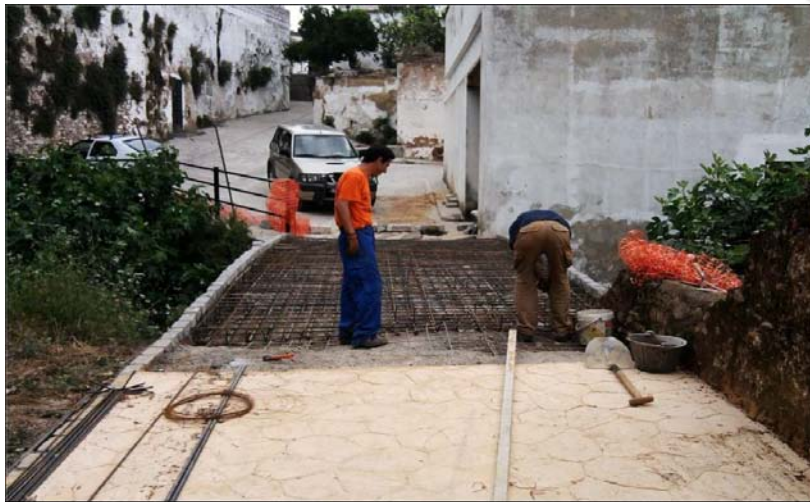
Lam. 2 Tramo 1 del Camino del Chorrillo. Proyectado de hormigón impreso. Vista desde el S.
