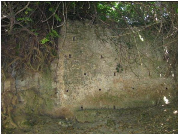
Lam. 11 Tramo 3.2 del Camino del Chorrillo. Utilización del travertino como muro ataludado
