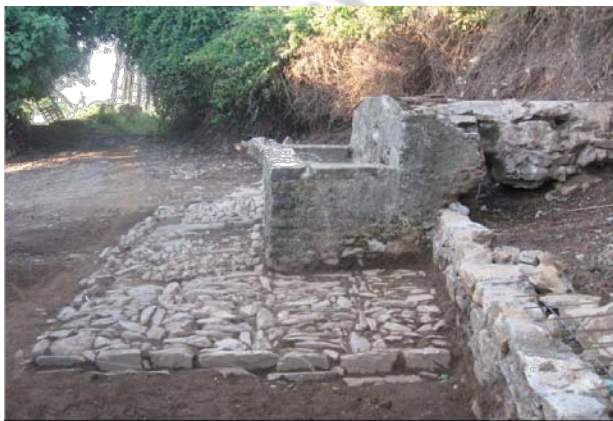
Lam. 6 Tramo 3.1. Fuente del Chorrillo
