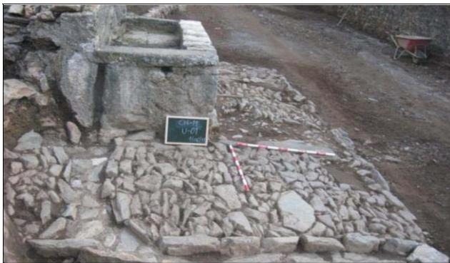
Lam. 9 Fuente del Chorrillo. Encachado de cantos y rebosadero
