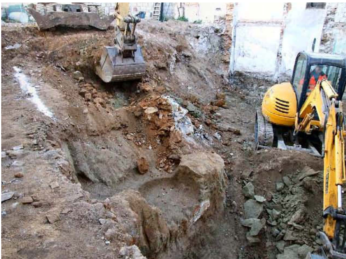
FIGURA 3. PROCESO DEL CONTROL DE MOVIMIENTO DE TIERRAS
