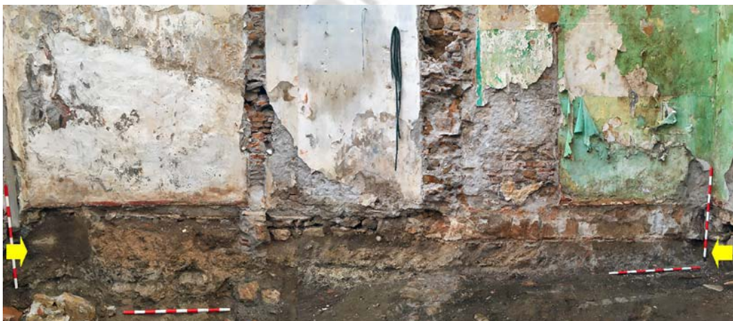
FIGURA 9. VISTA GENERAL DEL MURO A24 (FASE III) SOBRE LA MEDIANERA NORTE DE LA PARCELA
