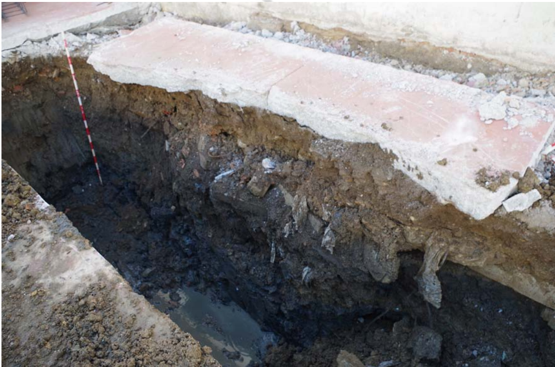
Fig. 2. Imagen de una de las zanjas abiertas.
