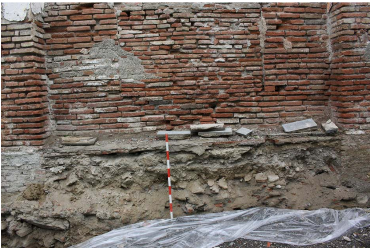
Figura nº 1: Perfil Nor-occidental de la parcela, en la que se encuentran relacionadas las viviendas colindantes con los depósitos sedimentarios que conforman el subsuelo de la parcela nº 20 de la calle Federico Macías.
