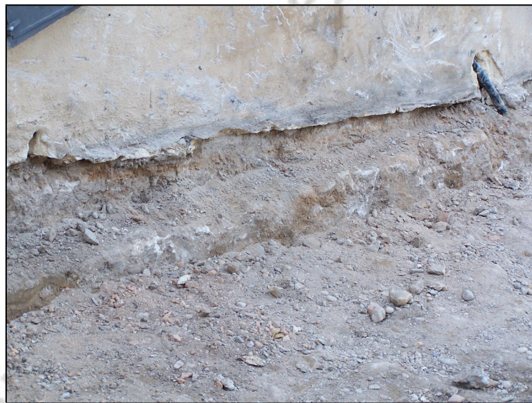
Lámina IV: Detalle de la base de cimentación de la trasera de la Logia del Castillo-Palacio de los Ribera.
