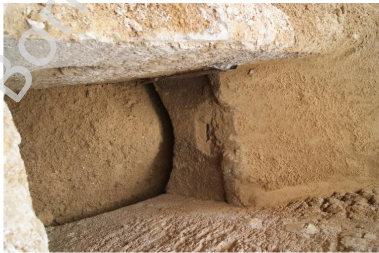
FIG 4 Proceso de relleno del pozo
