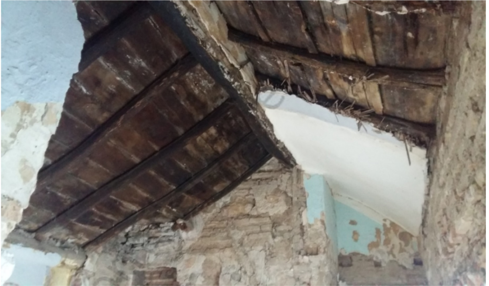
Lám.11- Desarrollo de la cubierta en estancias 12-15 con tablazón y cañas sobre escayola.
