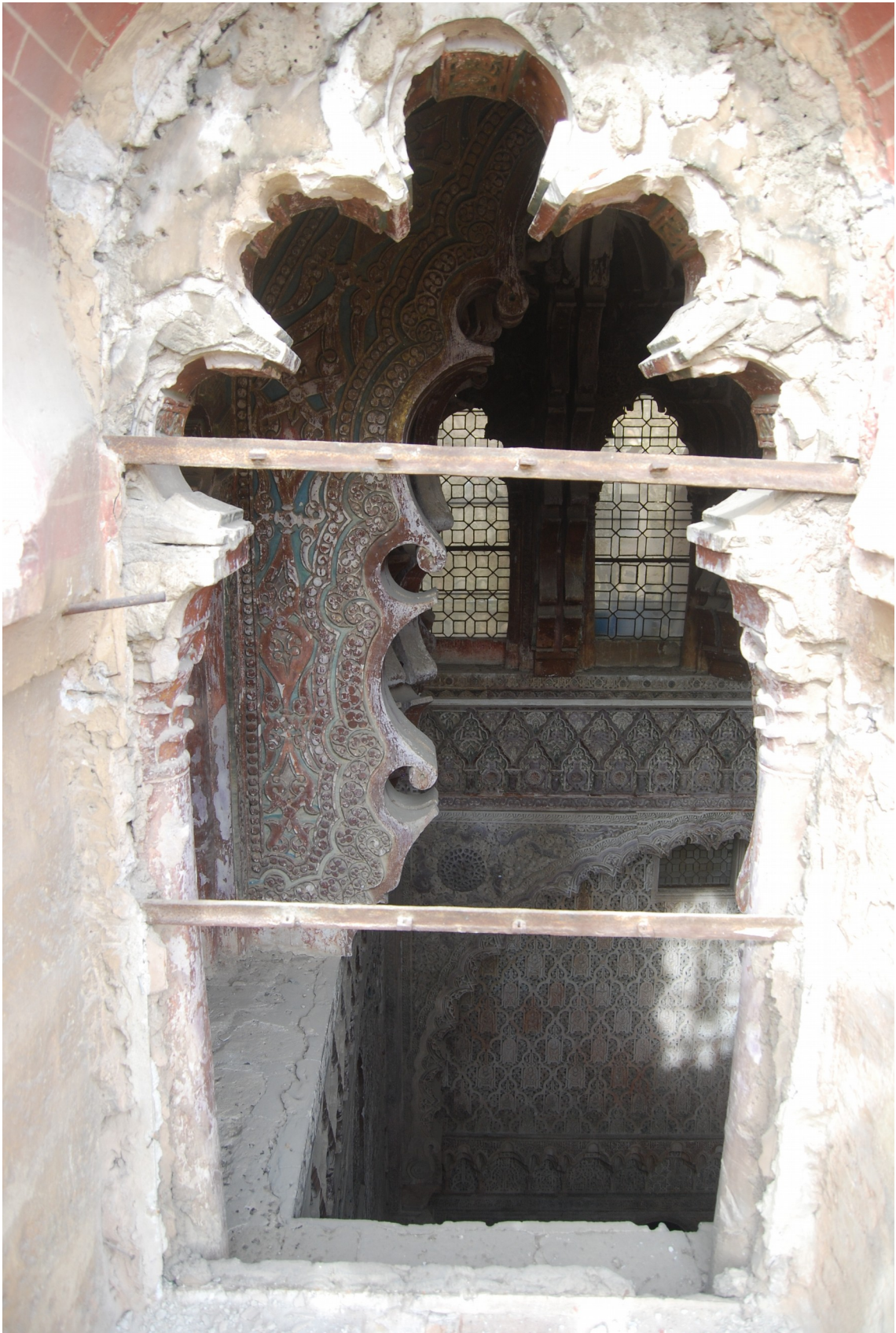
Figura 6: Retirada de celosías de Capilla Real.
