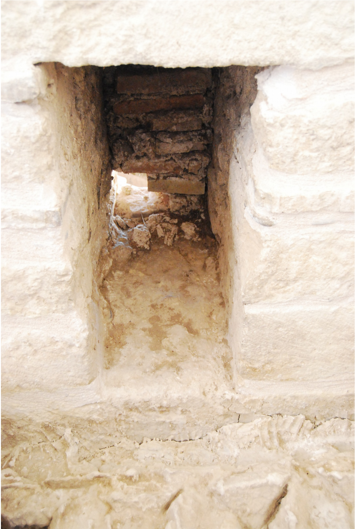
Figura 7: Cegamiento de los vanos de la cubierta de Capilla Real.
