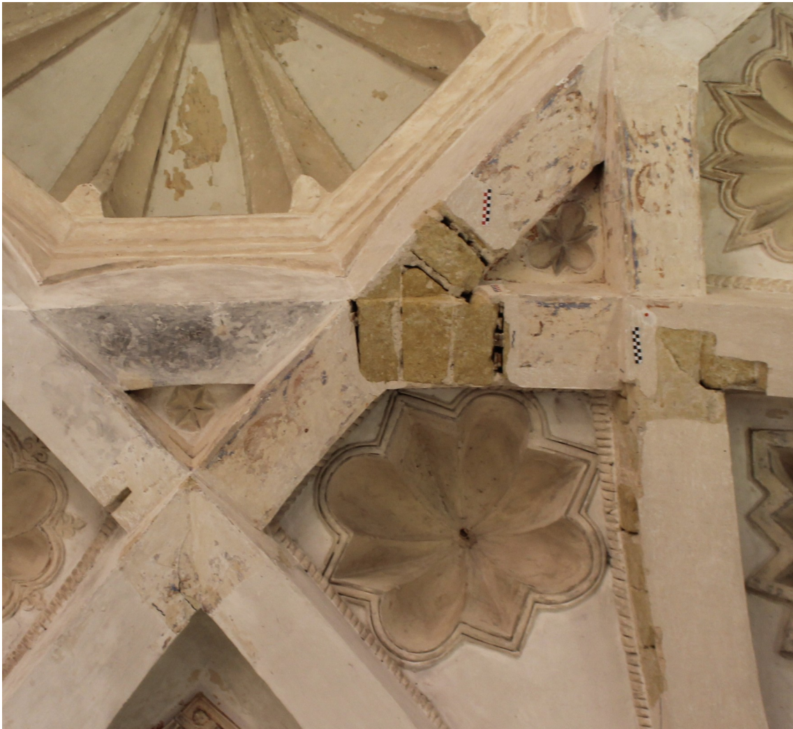
Figura 10: Estado final de los sondeos 1, 2 y 3, en los que se han observado tanto las decoraciones originales como el núcleo constructivo de dovelas de piedra calcarenita.
