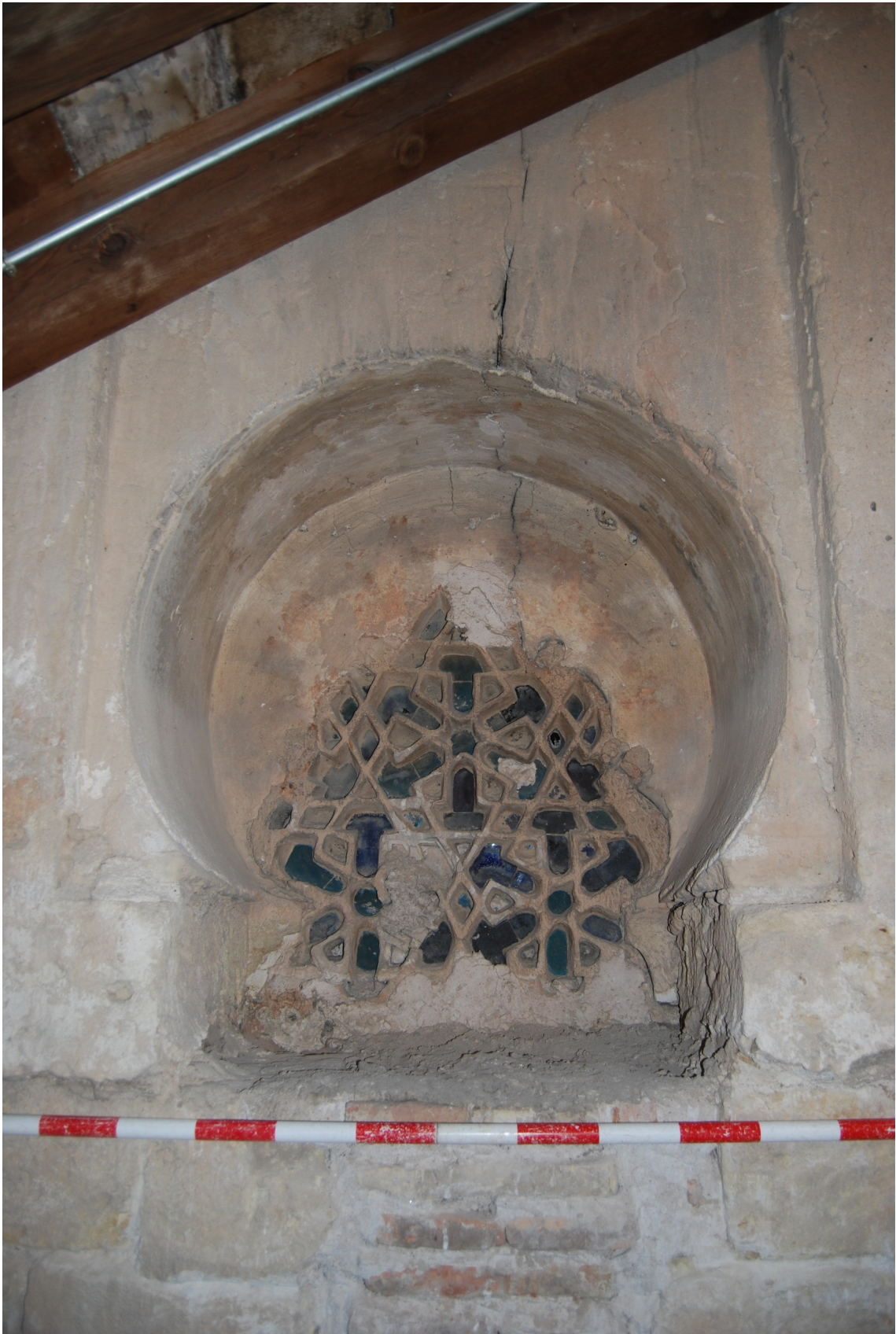
Figura 5: Detalle de la vidriera en el alzado oeste de Capilla Real
