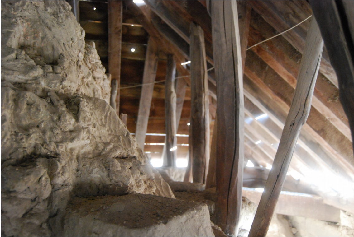
Figura 8: Jabalcones en el interior de la cubierta de Capilla Real.
