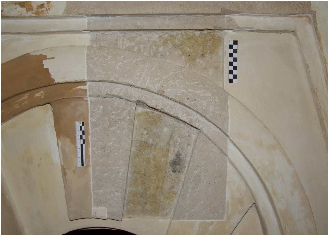
Figura 12: Estado final del Sondeo 15, en el que se aprecian las reformas decorativas decimonónicas que repiten los esquemas califales originales.
