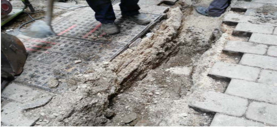
Retirada solería
