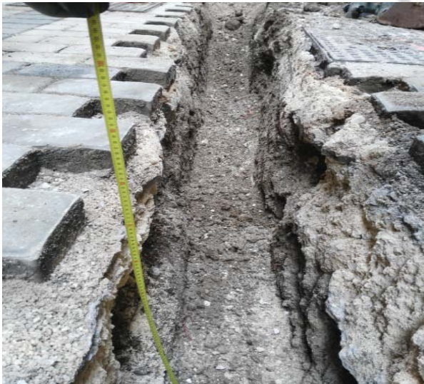
Vista de la zanja abierta para la acometida
