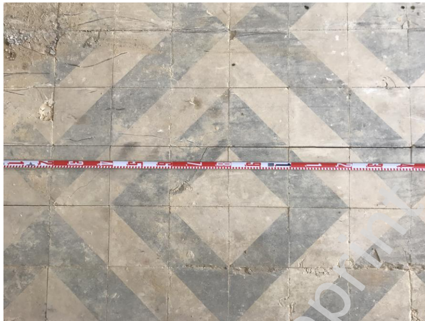
Lámina V. Pavimento de losas de cemento hidráulico, asociado a la fase contemporánea de la vivienda demolida.
