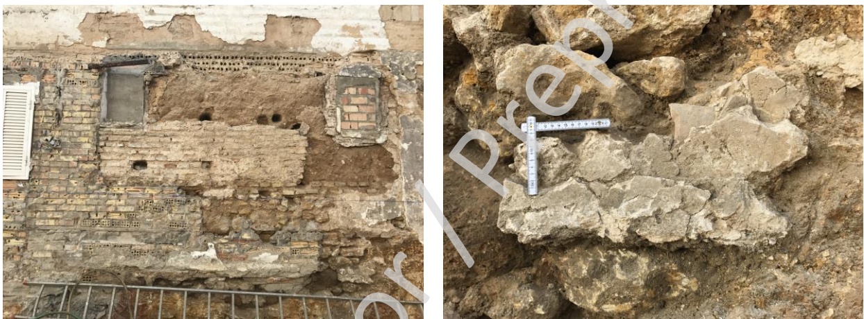
Lámina III. Restos conservados de la medianería del molino en el paramento norte de la parcela.
