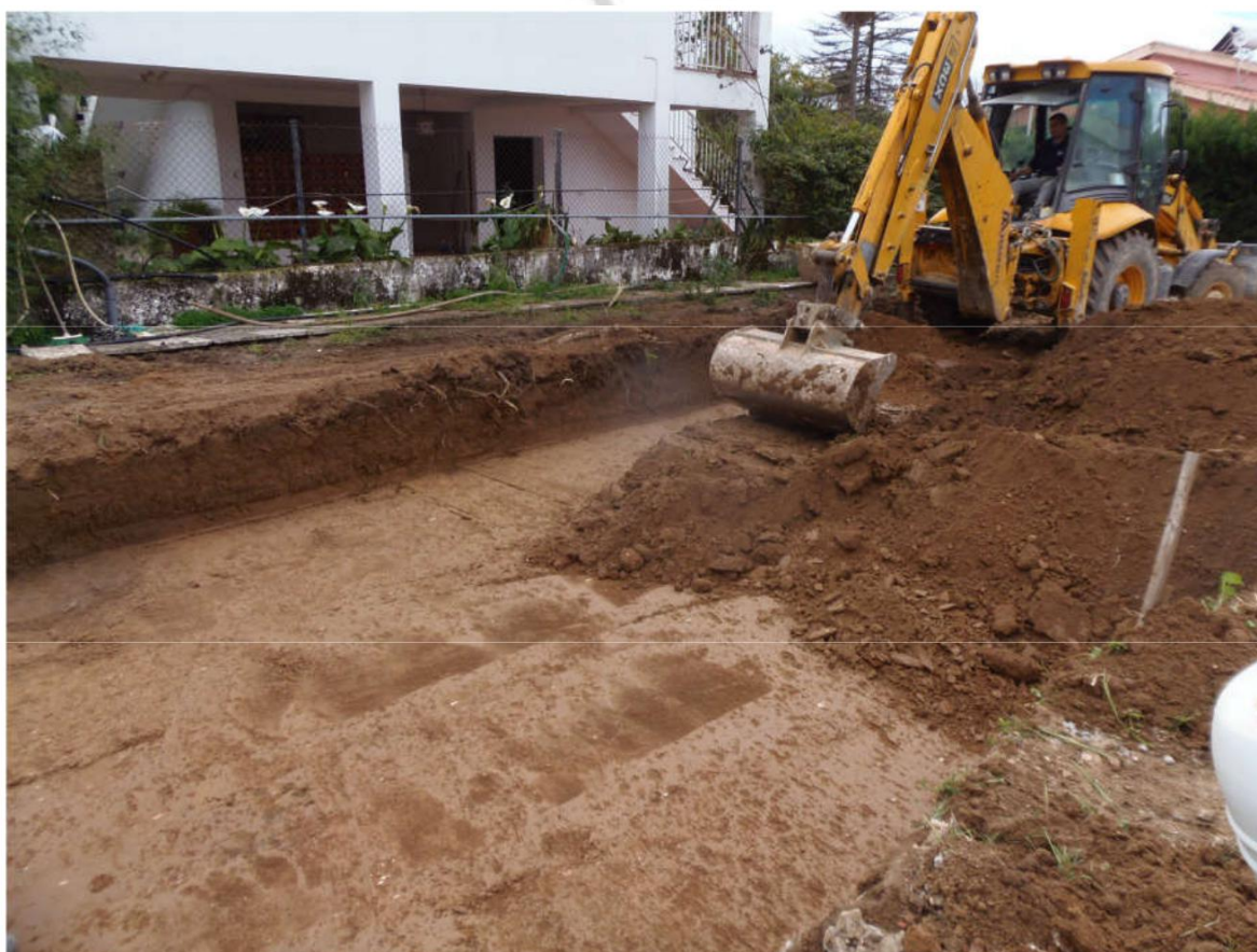
Figura 4. Control de las máquinas durante el rebaje del solar
