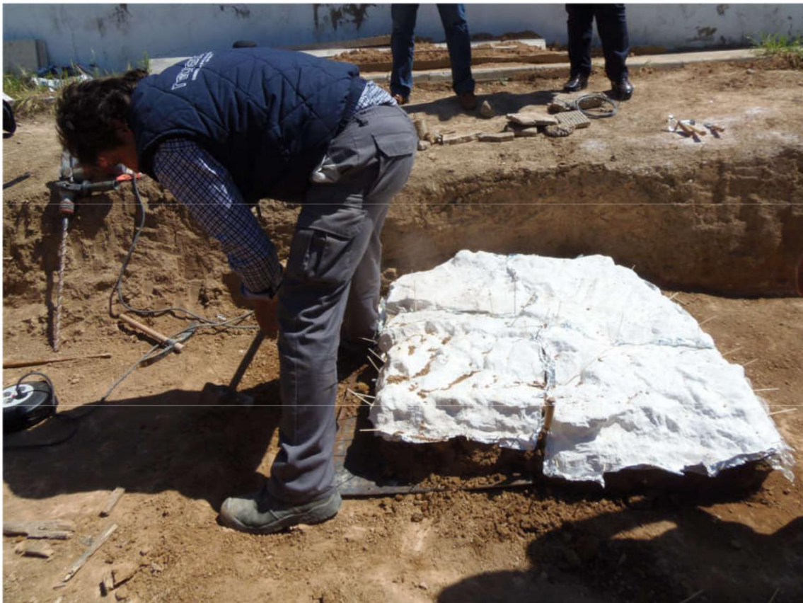
Figura 24. Clavado de la plancha de acero bajo uno de los cuadrantes de la estructura
