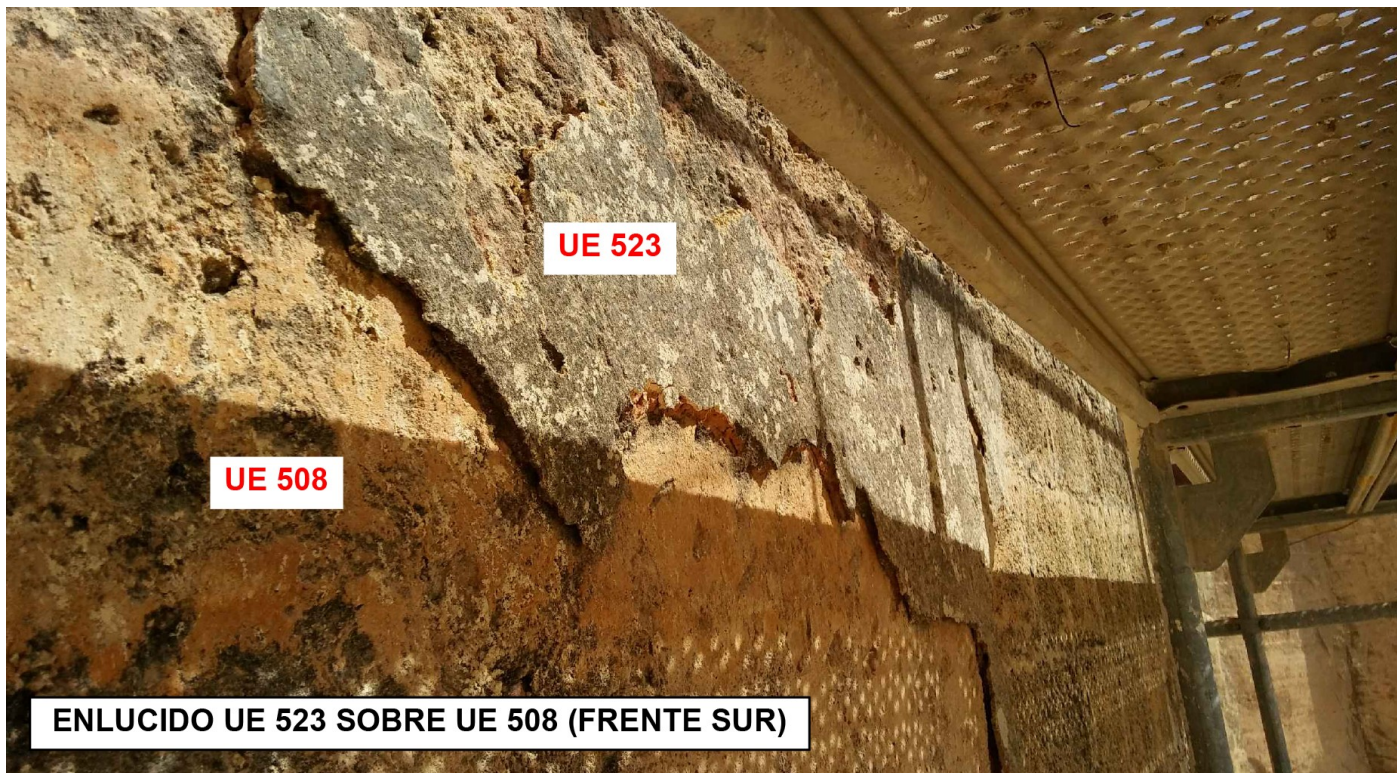
Lámina 9: Restos de enlucido sobre el frente sur.
