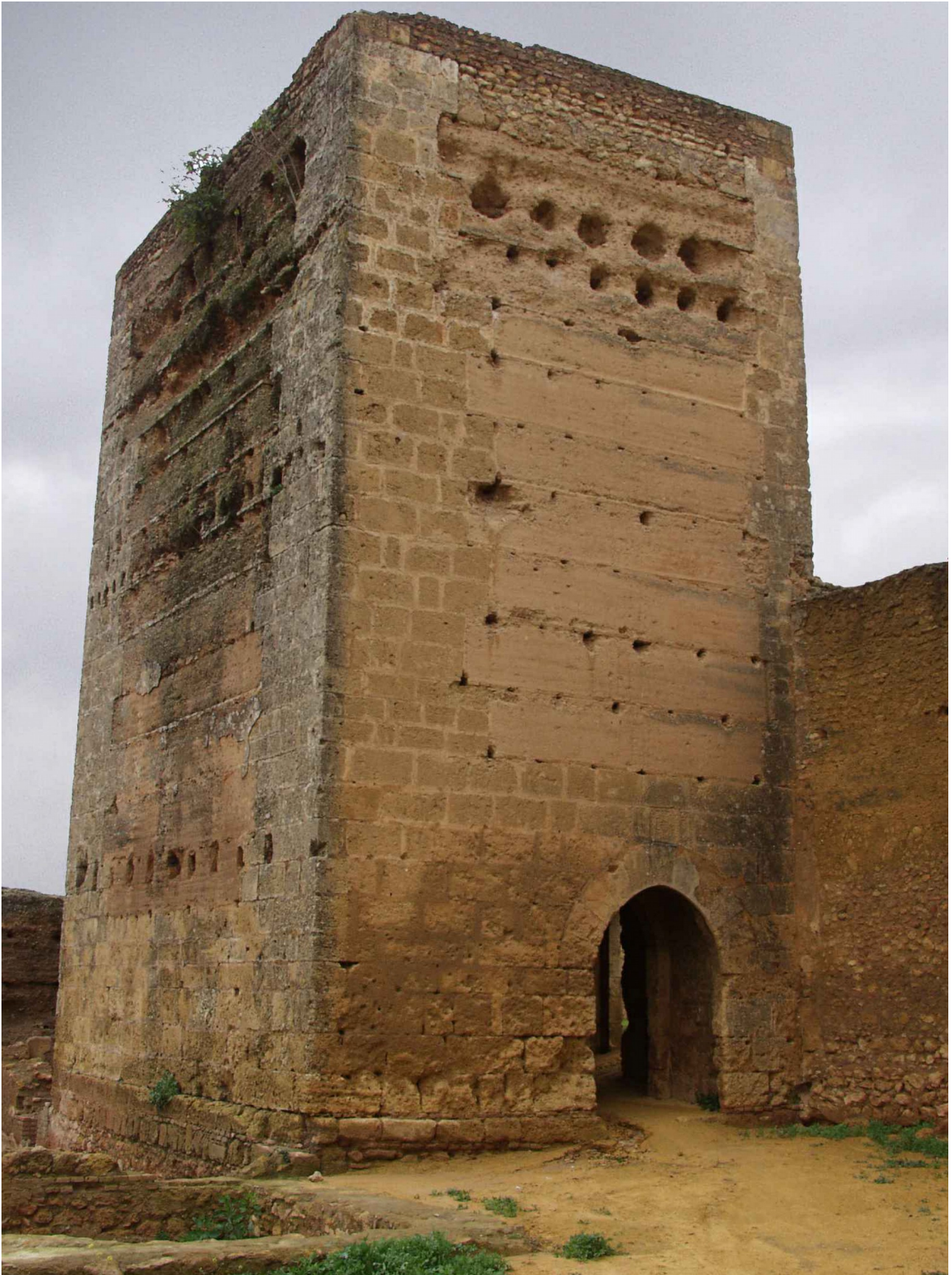
Lámina 3: Torre 9 desde el sureste (año 2004).
