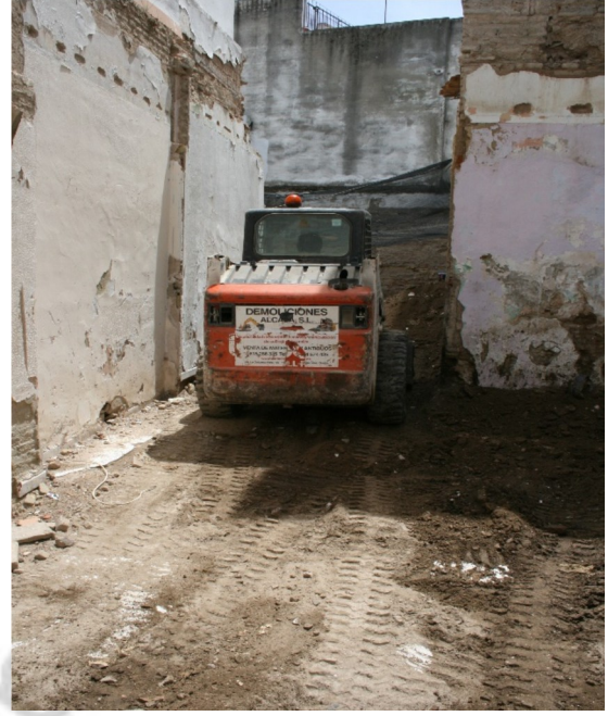
Lám.7. Maquinaria utilizada para el rebaje.
