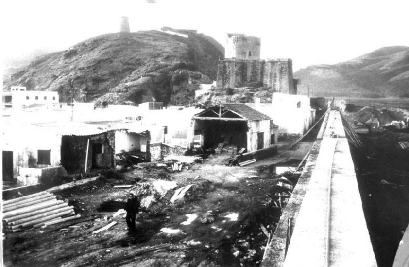
Reconstrucción del muro contención para las riadas del Barranco o Rambla de Las Angosturas próximo al entorno del Castillo. (1973)
