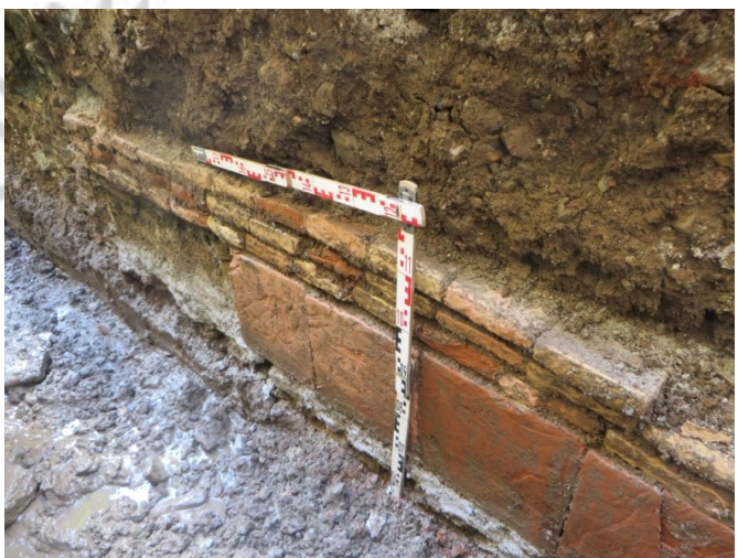
Muro lateral acequia muro
