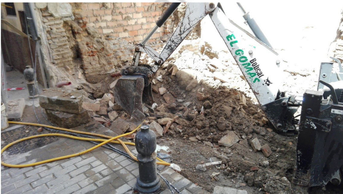
FIG. 3: DETALLE DE LOS TRABAJOS DE LIMPIEZA Y EXCAVACIÓN
