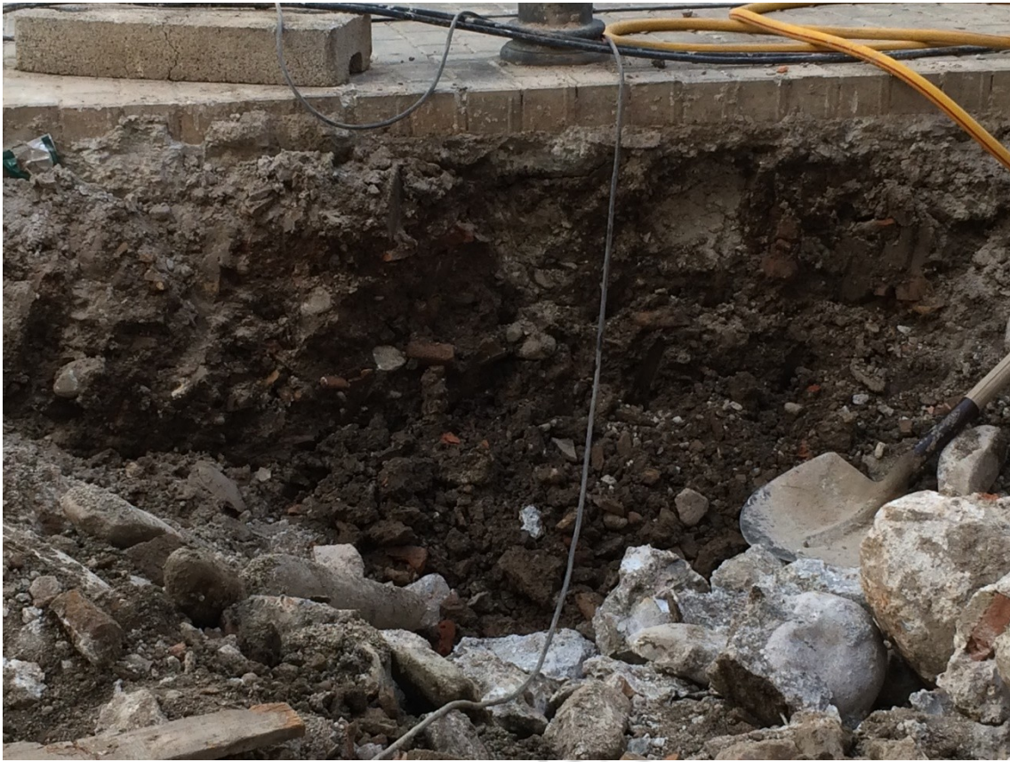
FIG.6: DETALLE DE UNO DE LOS PERFILES DURANTE LA EXCAVACIÓN
