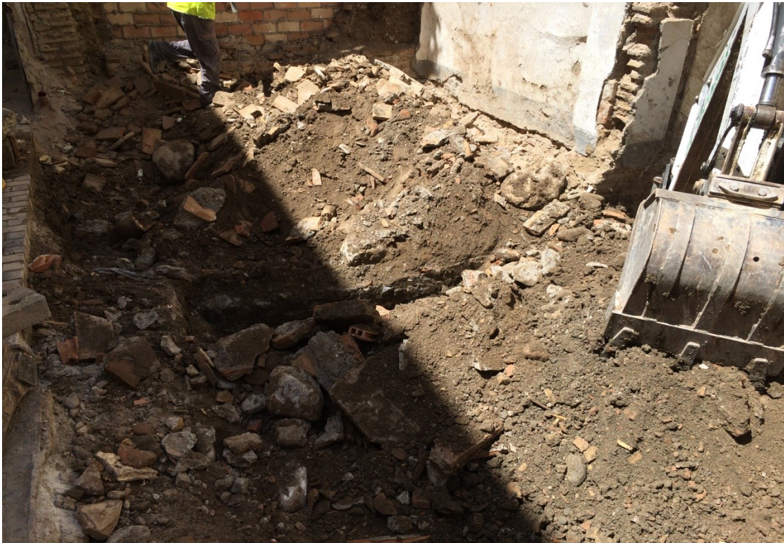
FIG.4; DETALLE DE LOS TRABAJOS DE LIMPIEZA Y EXCAVACIÓN
