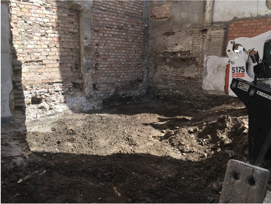
FIG.7: VISTA DEL ESTADO FINAL TRAS LA EXCAVACIÓN
