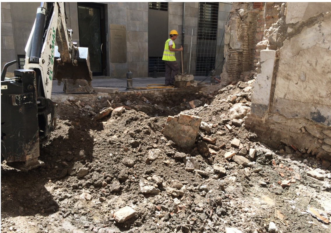
FIG.5: DETALLE DE LOS TRABAJOS DE LIMPIEZA Y EXCAVACIÓN
