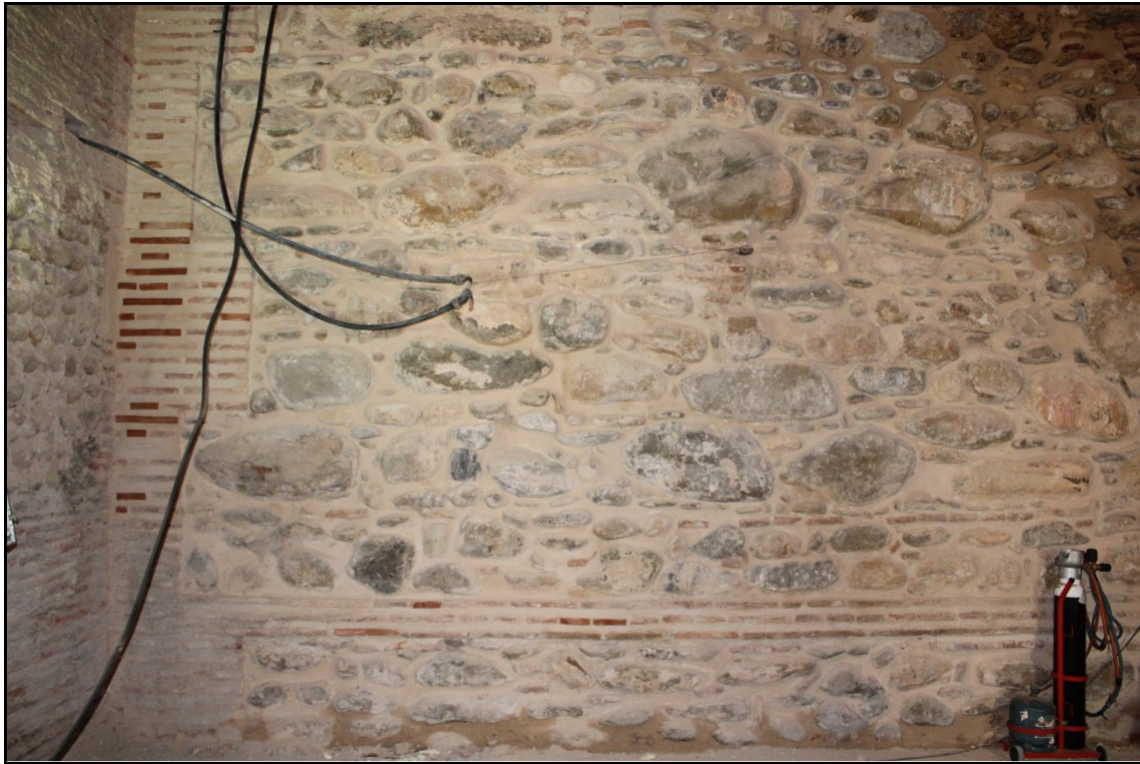
Imagen: Muro de cierre norte. Se aprecia parte de la fábrica de mampostería encintada.
