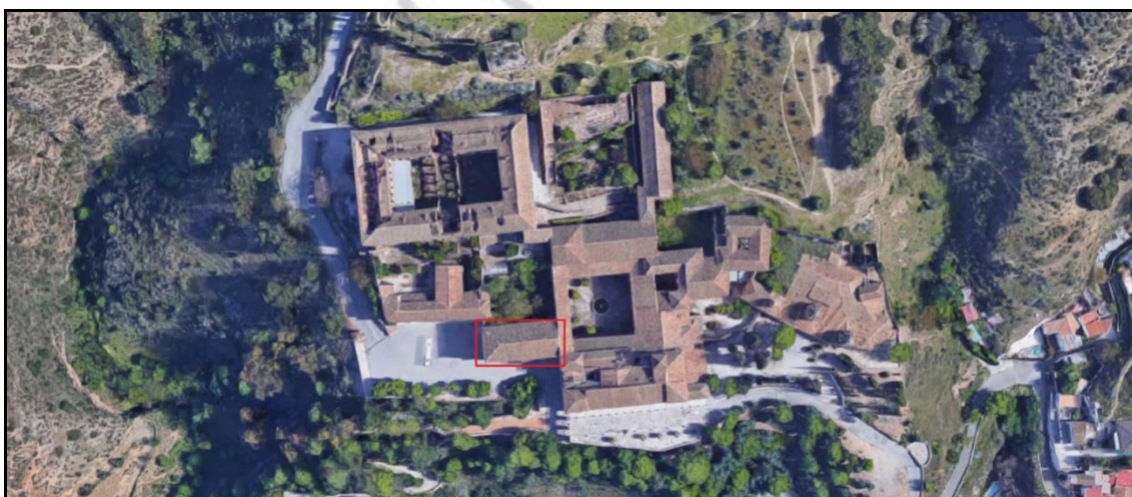
Imagen: Localización de la actuación (recuadro en rojo) Sala de Recepción Abadía del Sacromonte.
