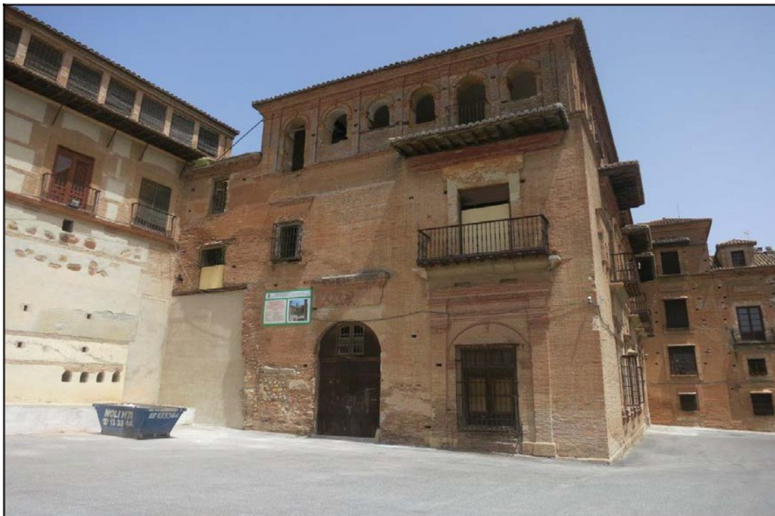
Imagen: Fachada oeste de la antigua Biblioteca antes del inicio de los trabajos de restauración 32 .
