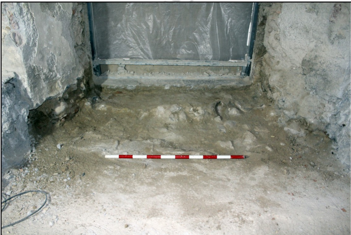
Imagen: Detalle de los restos arrasados de la cimentación, UE-006 , de argamasa de cal y bolos, una vez desmontado el escalón UE-008 .
