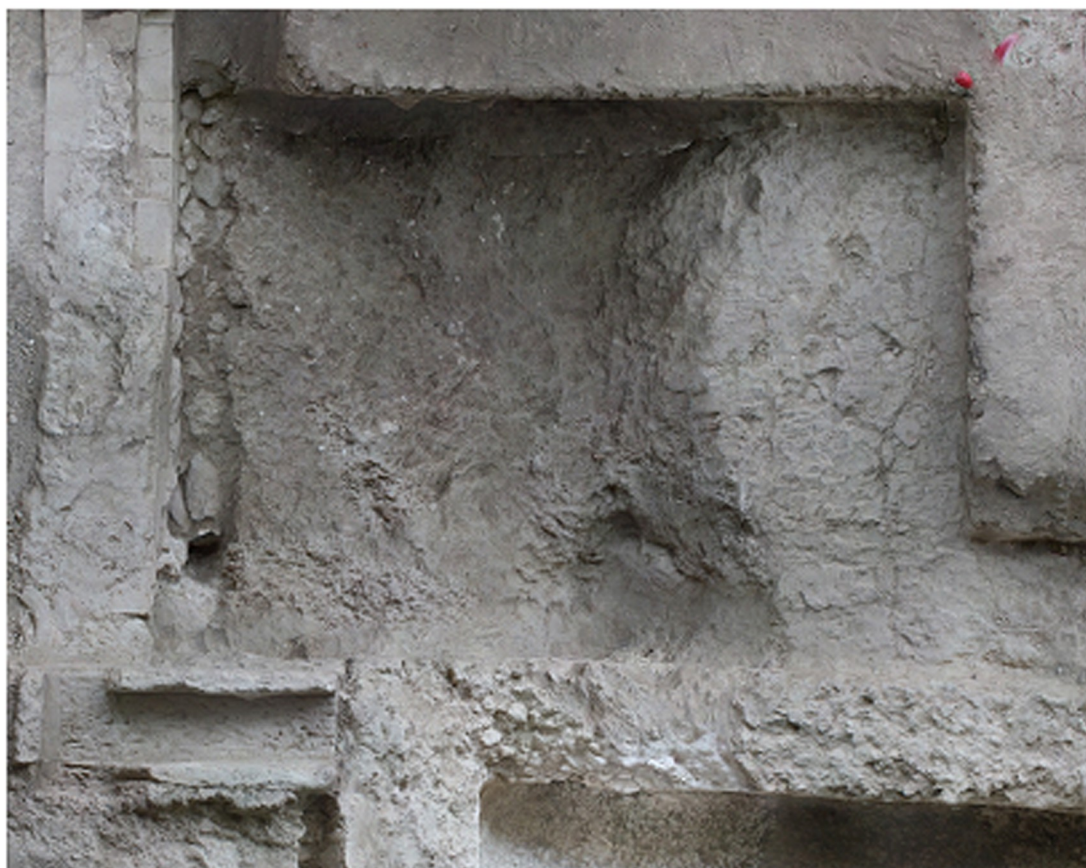
Figura 4. Infografía del Sondeo 1, con la representación gráfica del perfil NO sobre la restitución ortofotogramétrica del mismo al término de los trabajos.
