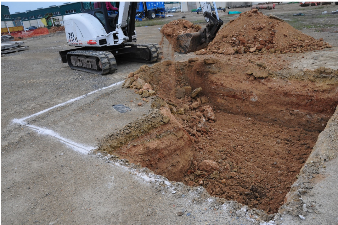
Lám. XII. Sondeo 3. Excavación de los niveles de relleno.
