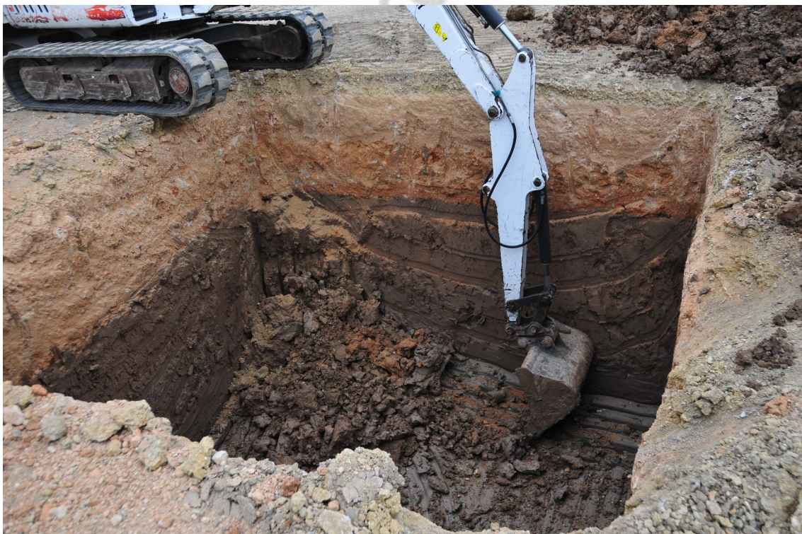
Lám. IX. Sondeo 2. Proceso de excavación.
