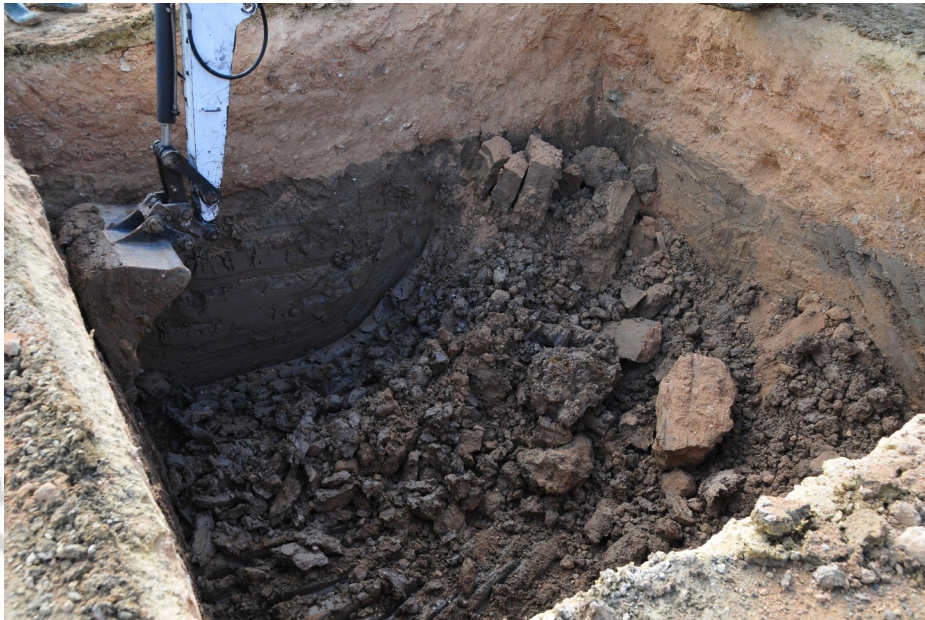
Sondeo 4. Proceso de excavación.
