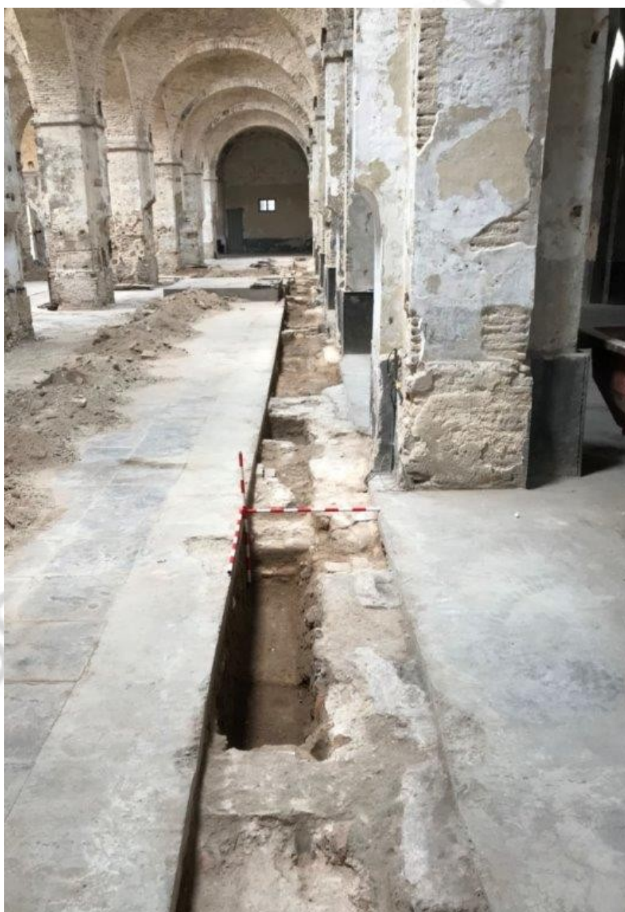
FIGURA 17. Vista general de la Zanja 10.
