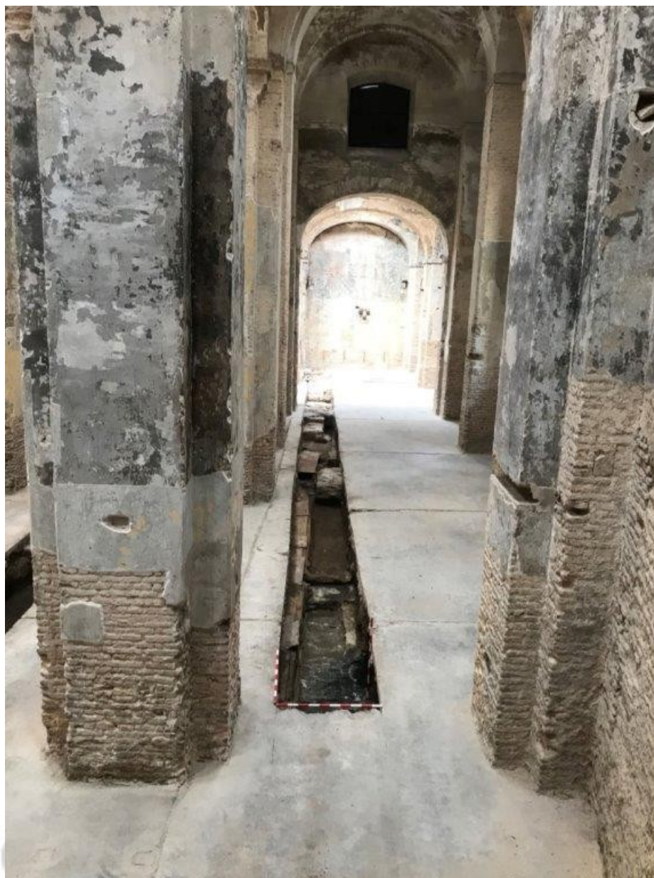
FIGURA 13. Vista general de la Zanja 7.
