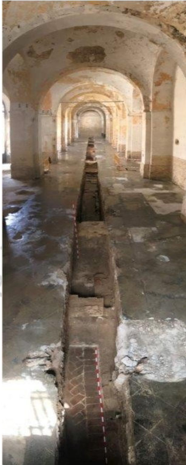
FIGURA 19. Vista general de la Zanja 12.
