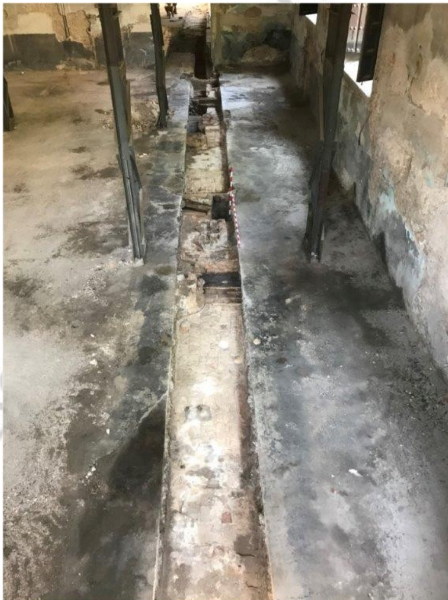
FIGURA 6. Vista general de la Zanja 2.
