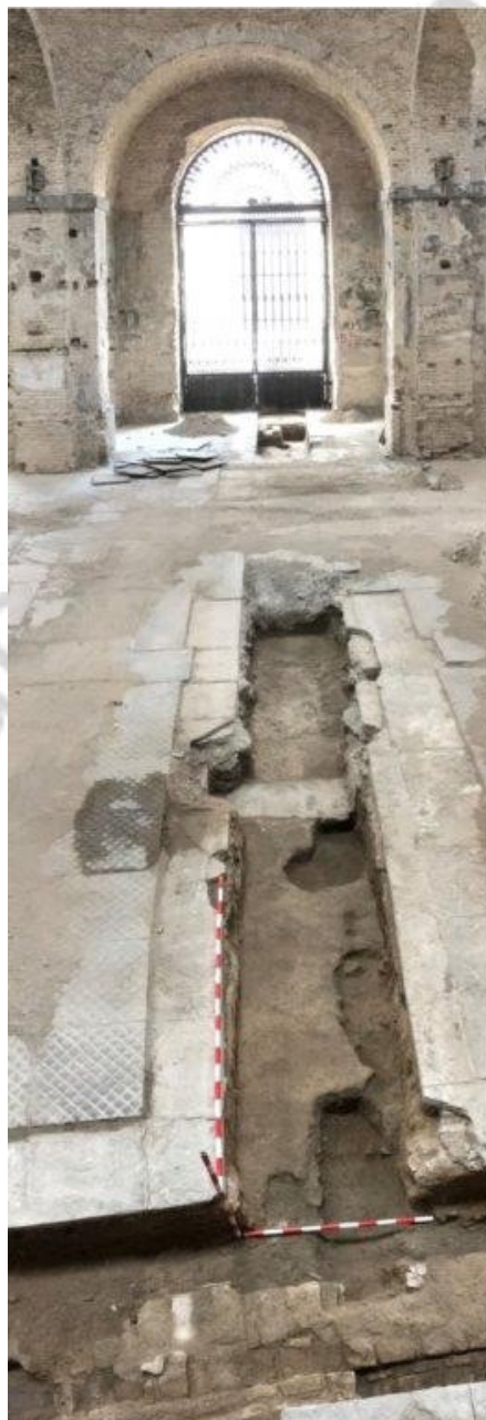
FIGURA 16. Vista general de la Zanja 9.
