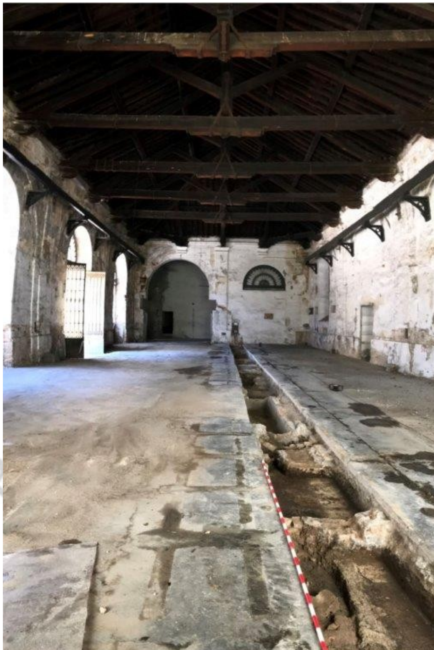
FIGURA 20. Vista general de la Zanja 13.
