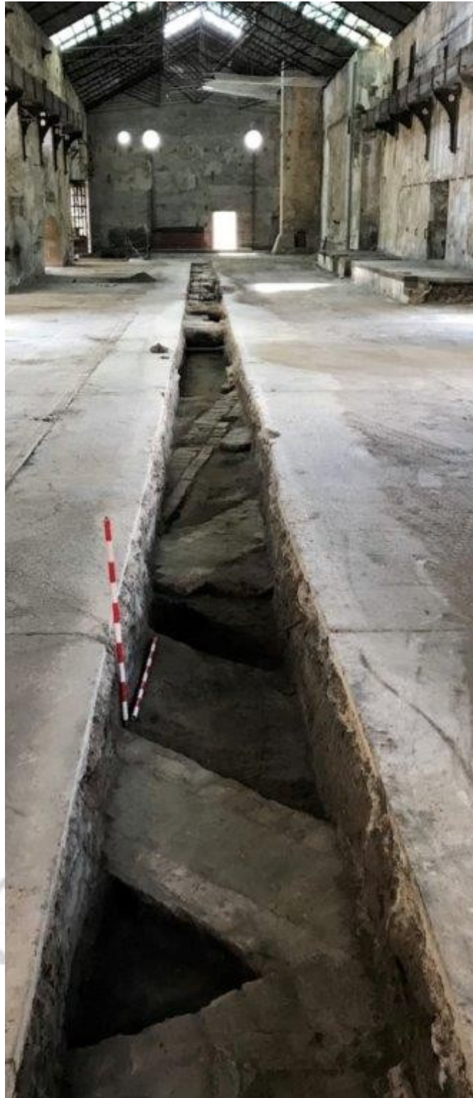
FIGURA 22. Vista general de la Zanja 15.
