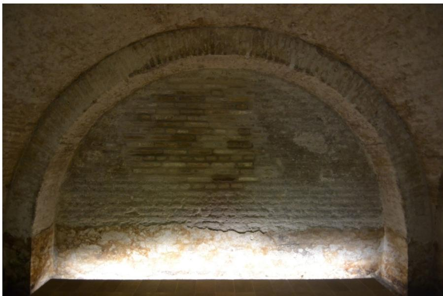
**Figura 34.** Paramento norte del semisótano en estancia 3 donde se ha llevado a cabo el cerramiento del muro.
