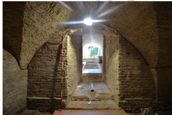
**Figura 24.** Recuperación de los escalones y pavimentos originales de la puerta de salida al Jardín de Troya.
