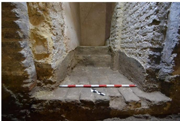
**Figura 21.** Detalle del pavimento de losas cerámicas perteneciente a la escalera original de acceso al palacio y del enlucido conservado bajo el relleno de escombros existente.
