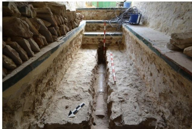
**Figura 25.** Sistema de saneamiento que anulaba el pavimento original de la puerta de salida al Jardín de Troya.
