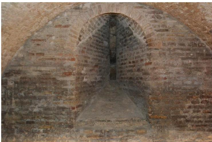
**Figura 19.** Detalle de la recuperación de única saetera original conservada en el semisótano tras las tareas de limpieza. Adviértase la recomposición del arco, originalmente ojival y su sustitución por uno de medio punto y rosca de medio pie, tal vez realizada durante las obras del siglo XVI.
