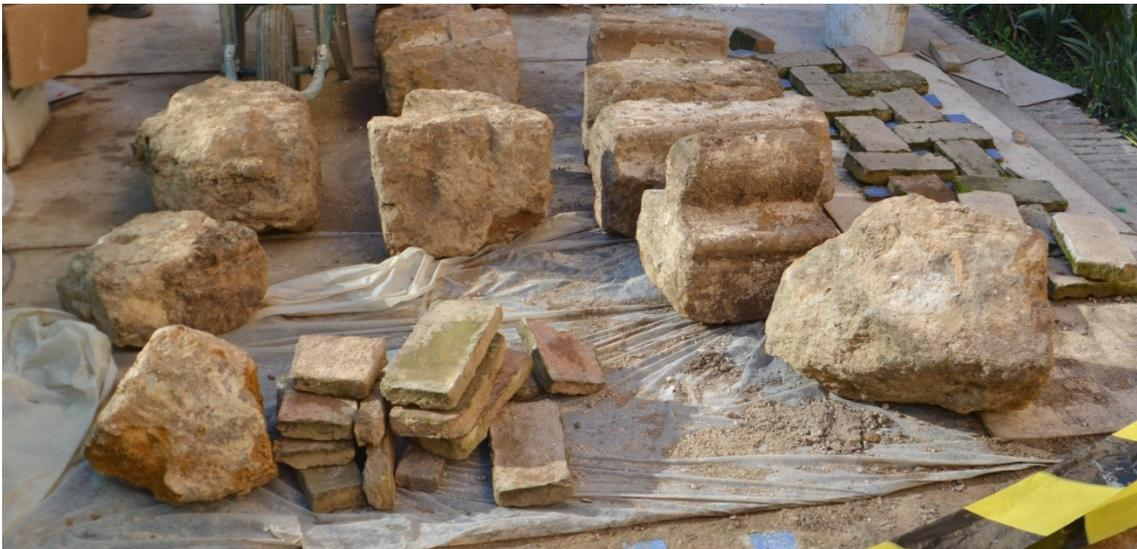
**Figura 44.** Acumulación de nervaduras y material constructivo procedente del interior de la escalera.
