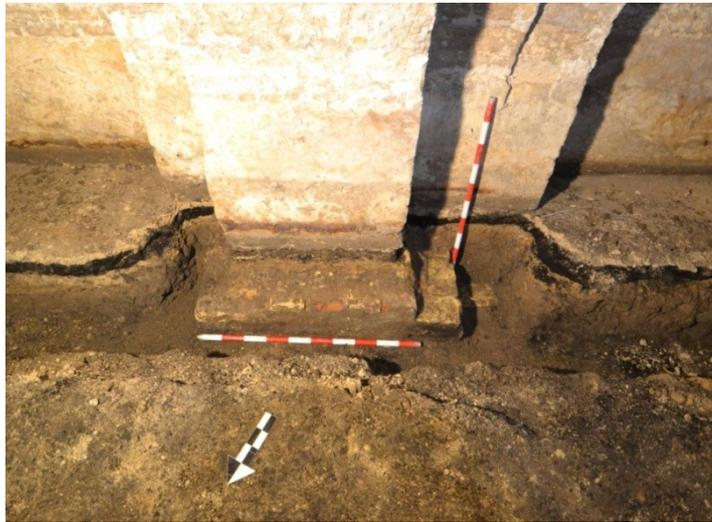
**Figura 31.** Zanja realizada en la cimentación de uno de los arcos perpiaños del muro sur del semisótano en la estancia 3.
