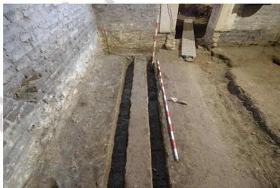
**Figura 22.** Zanjas realizadas para la introducción de los sistemas de ventilación del nuevo pavimento
