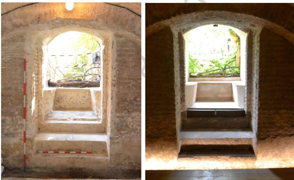
**Figura 28.** Estado previo del segundo acceso desde el extremo oriental de la Sala 3 una vez abierto el cegamiento y estado actual tras la finalización de los trabajos
