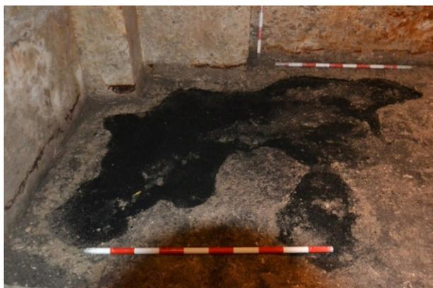
**Figura 16.** Detalle de la ruptura en el pavimento dejando al descubierto la capa de ceniza de su preparación.
