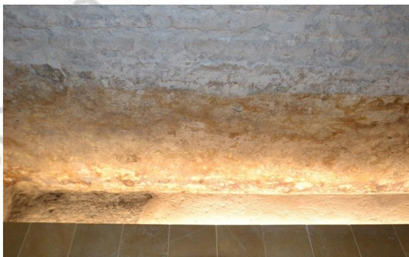
**Figura 35.** Limpieza del pavimento original a la izquierda y restitución del mismo a la derecha.
