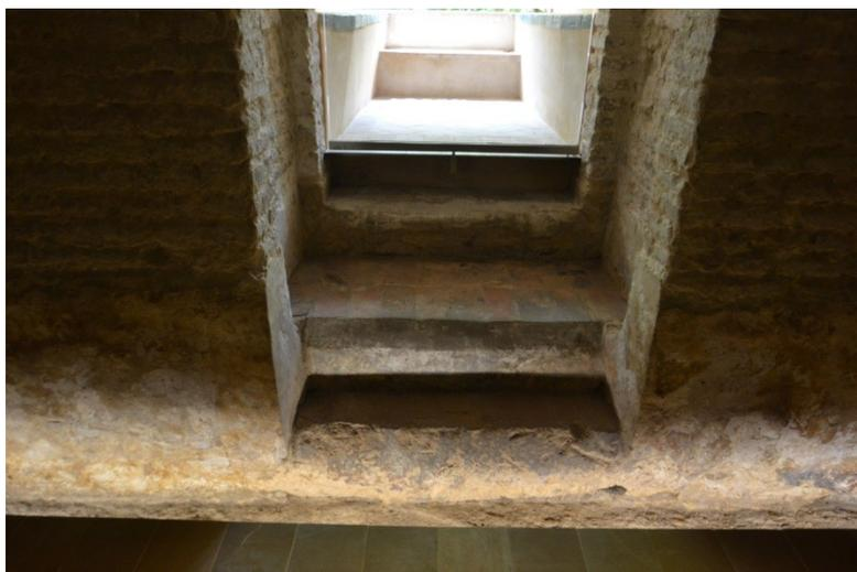
**Figura 27.** Estado final tras la recuperación de los escalones originales de la entrada de acceso al semisótano.
