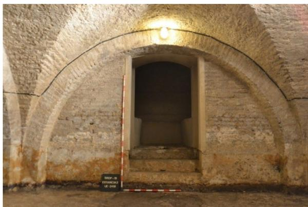
**Figura 14.** Vista de una de las aperturas hacia los jardines tras la excavación. Se han recuperado los peldaños y pavimentos originales. Cada una de ellas ocupa el espacio de una antigua saetera de iluminación perteneciente al proyecto original del palacio.
