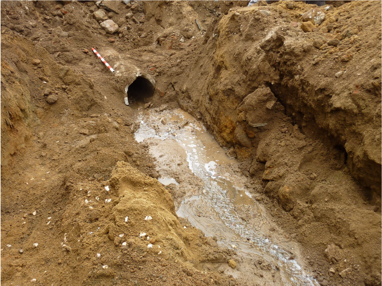
Fig. 3. Zanja con restos de saneamiento antiguo donde detectamos el firme geológico
