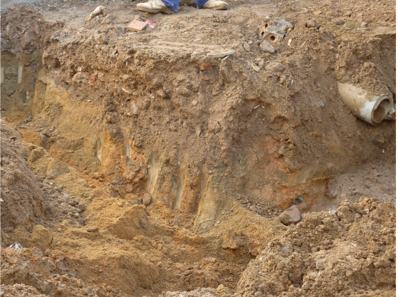
Fig. 4. Zanja para canalización de entrada a una vivienda donde detectamos el firme geológico
