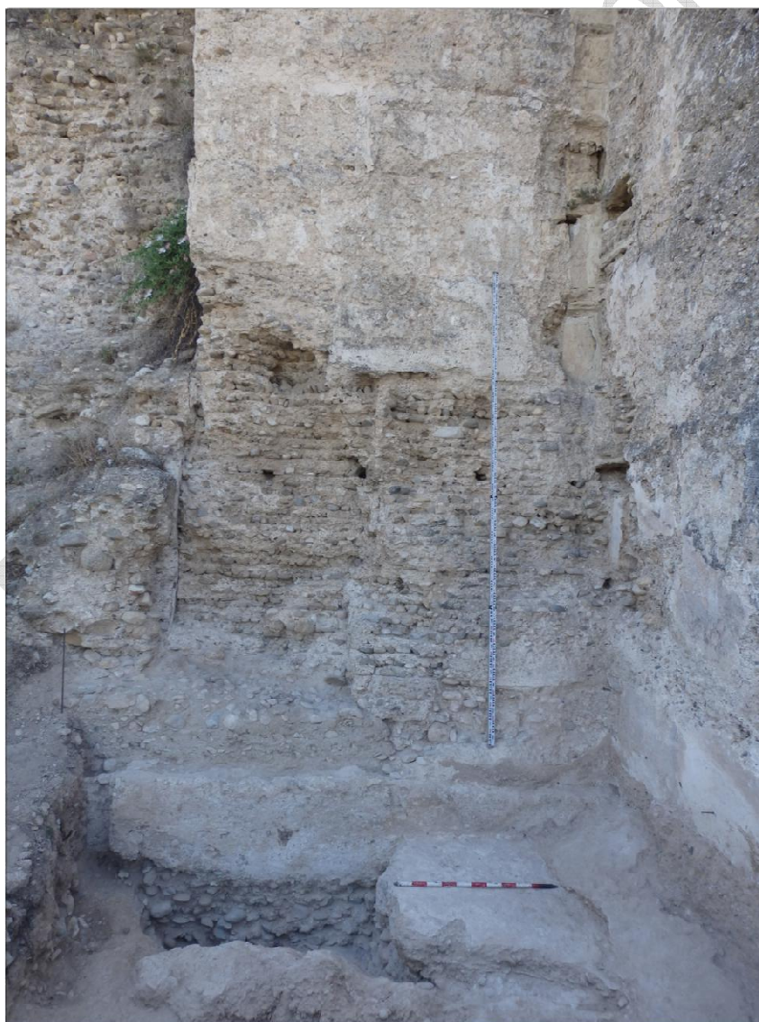
Fig. 8 Vista del sondeo 2000 desde el Oeste
