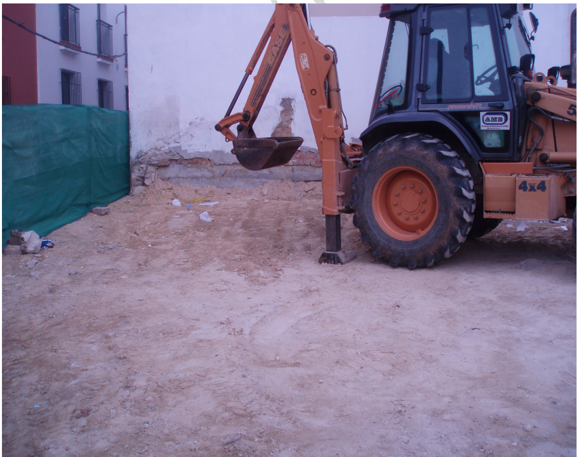
Foto 2.- Vista de parte del solar antes de iniciar excavación
