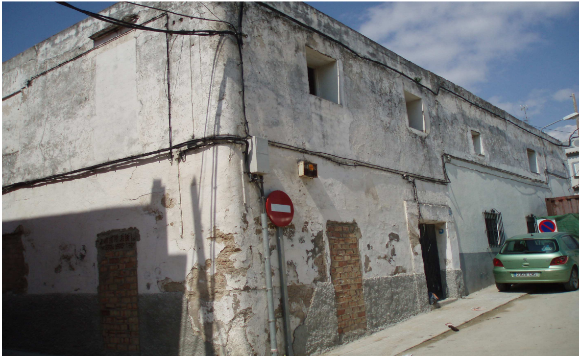
Foto 1.-Imagen donde aparece la vivienda existente en el lugar
