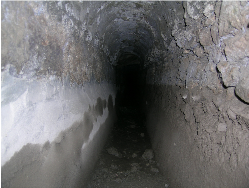
Sondeo 2 interior del acueducto
