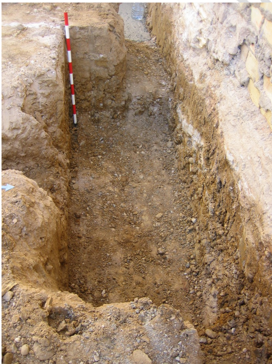
Lám. IV - Vista de zanjas y pozos para pilares.
