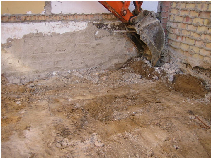
Lám. II - Vista de la excavación mecánica.
