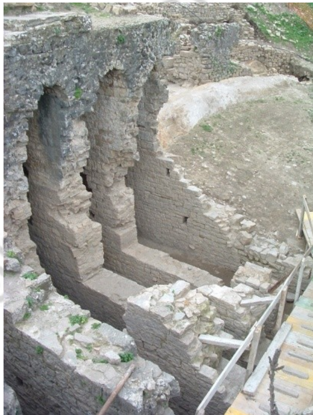
Fig.12. Vista de las bóvedas del basamento.
