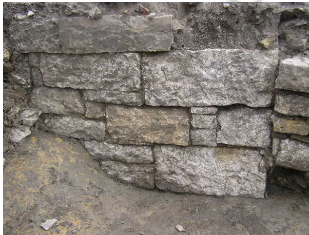
Fig.20. Jamba de la puerta de época augustea.
