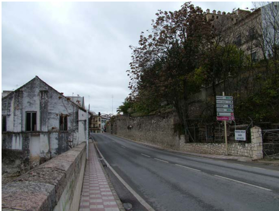
4. Situación del solar respecto la Torre del Homenaje (Puerta de Córdoba).
