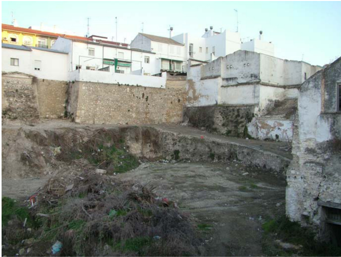
3. Panorámica del solar.
