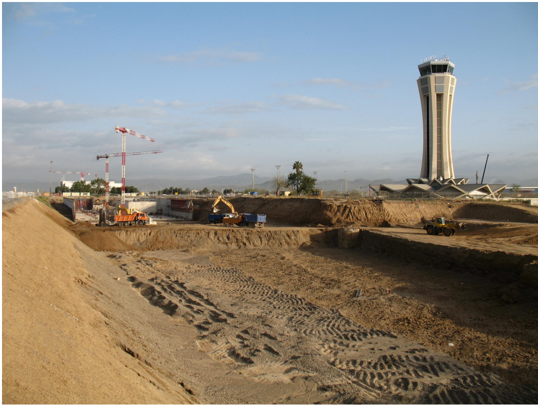
Lámina 4: Excavación Nuevo Edificio Terminal de Aviación Civil.
