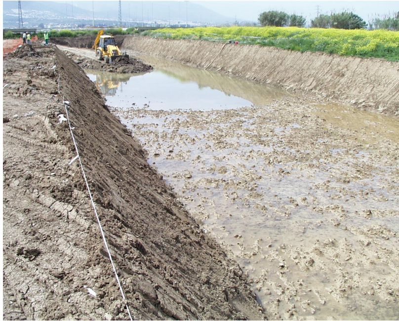
Lámina 2: Excavación Drenaje General.
