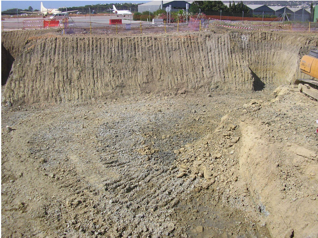
Lámina 3: Excavación Nuevo Edificio para Aviación General.
